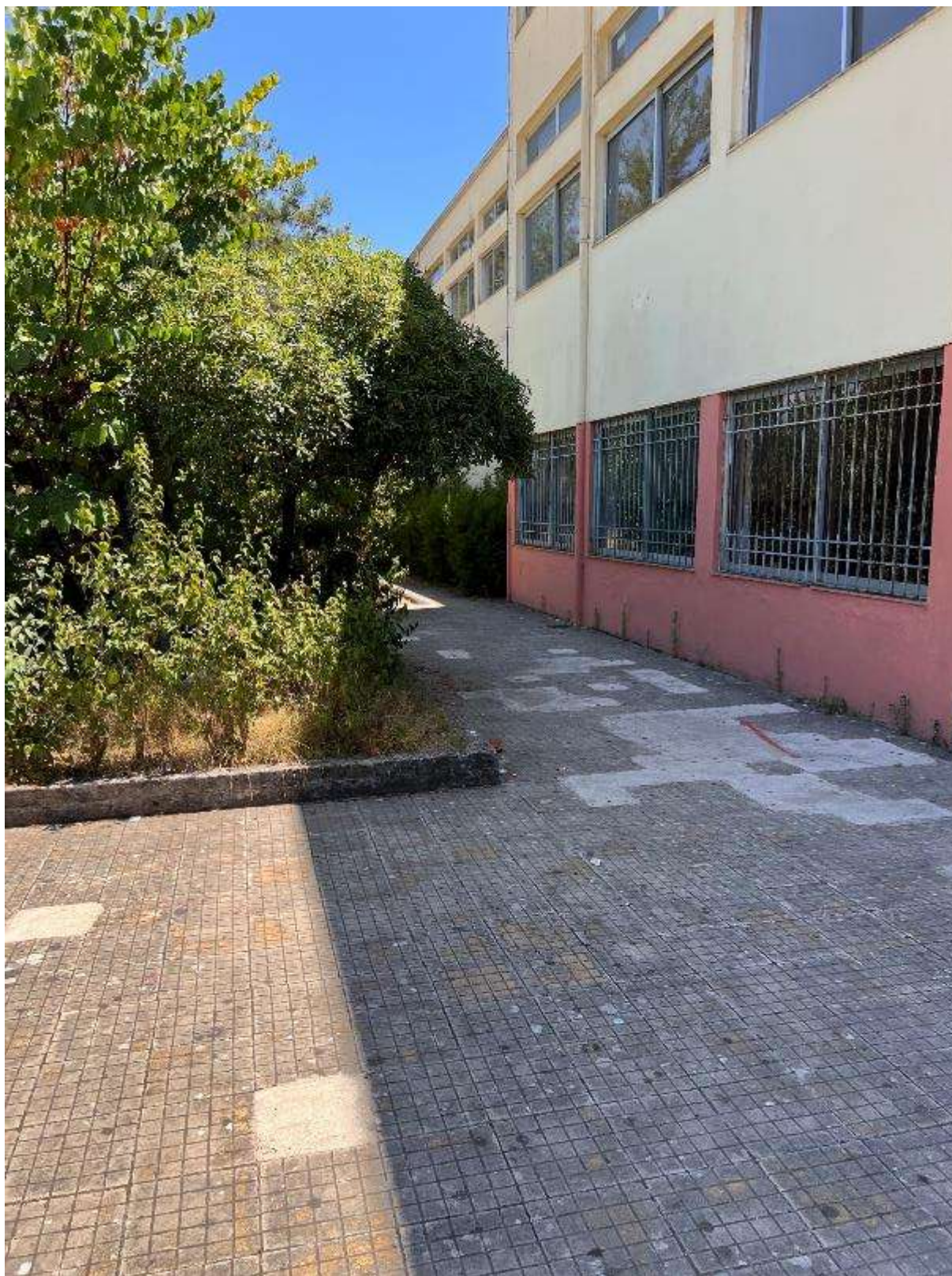
Εικόνα 236: Όψη 2 (Εσπερινό Γυμνάσιο & Εσπερινό ΓΕ.Λ Αρτας – Κωδικός θέσης: Δ.Κ._29)
