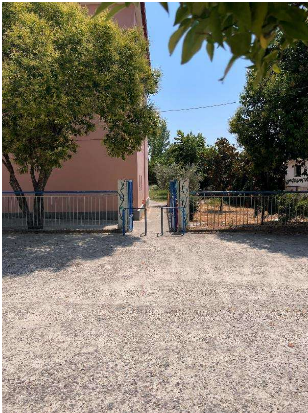
Εικόνα 298: Δευτερεύουσα είσοδος Πλάγια όψη (Νηπιαγωγείο & Δημοτικό Σχολείο Αγίου Σπυριδωνα – Κωδικός θέσης: Δ.Κ._53)
