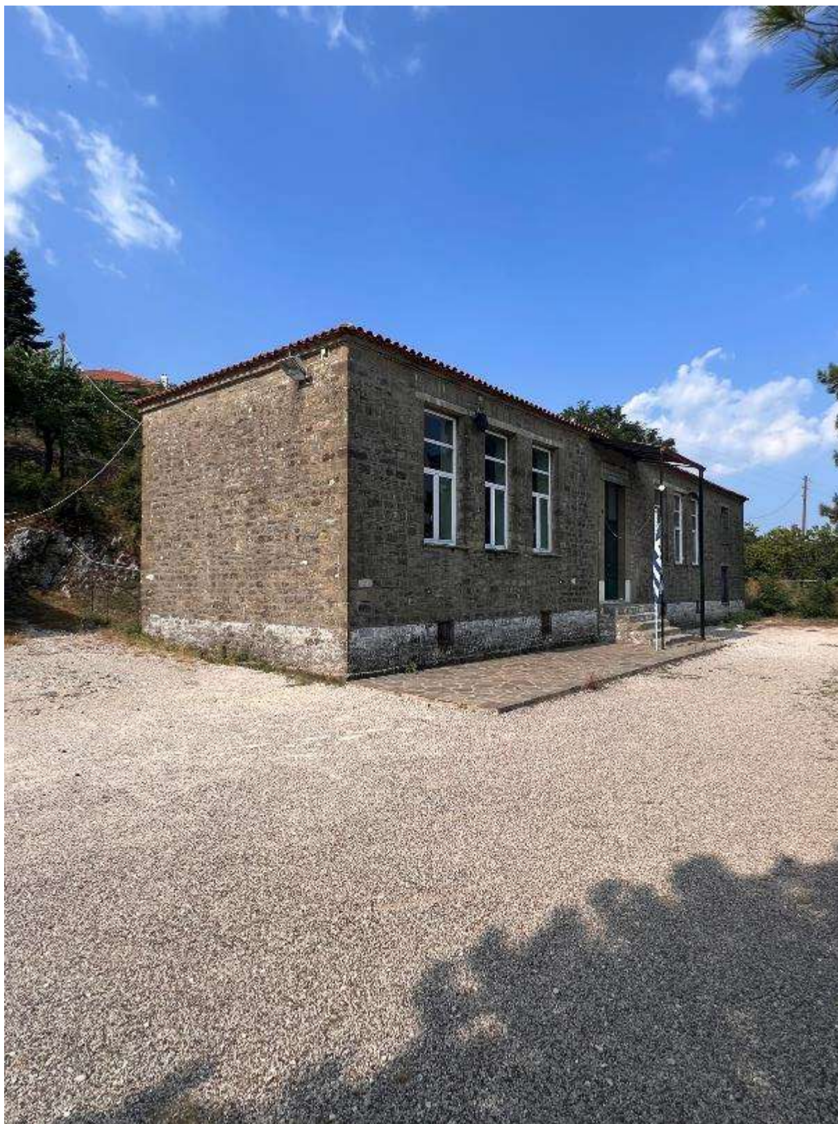
Εικόνα 318: Πλάγια όψη (Δημοτικό Σχολείο Ροδαυγής – Κωδικός θέσης: Δ.Κ._59)
