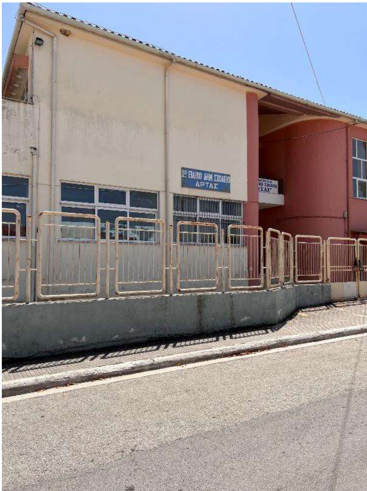
Εικόνα 243: Πλάγια όψη (Δημοτικό Σχολείο & Ειδικό Δημοτικό Σχολείο Ελεούσας – Κωδικός θέσης: Δ.Κ._32)
