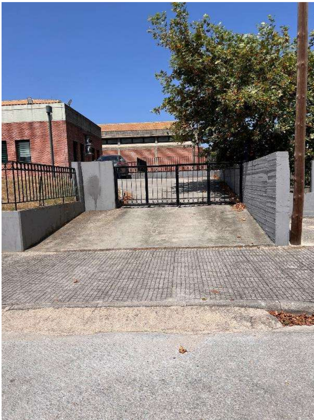
Εικόνα 149: Νοτιοανατολική όψη κτιρίου – ράμπα εισόδου στο κτίριο (Αρχαιολογικό Μουσείο Άρτας – Κωδικός θέσης: Δ.Κ._2)
