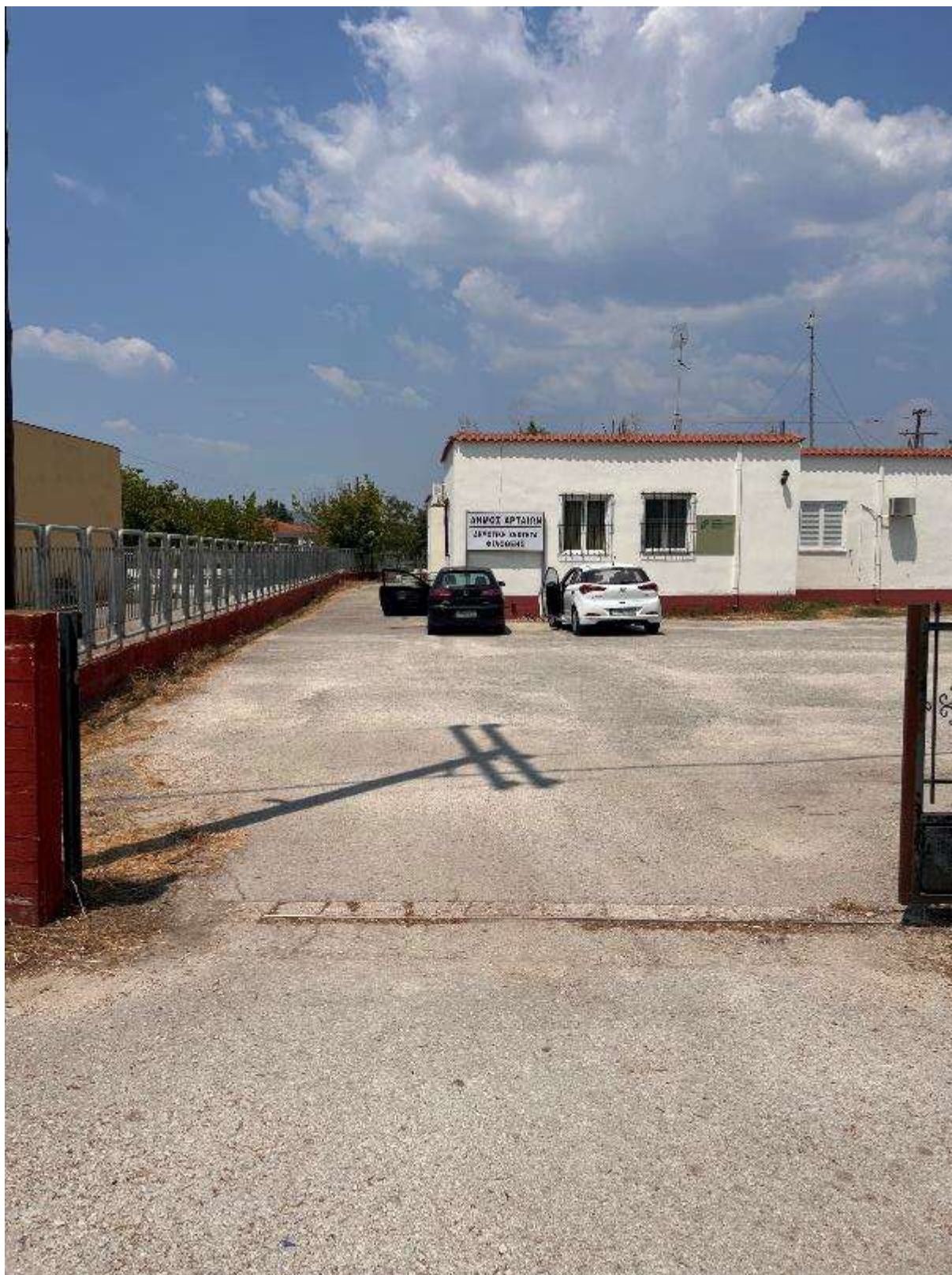
Εικόνα 324: Κεντρική είσοδος (Κτίριο Κ.Ε.Π Φιλοθέης – Κωδικός θέσης: Κ.Χ._62)
