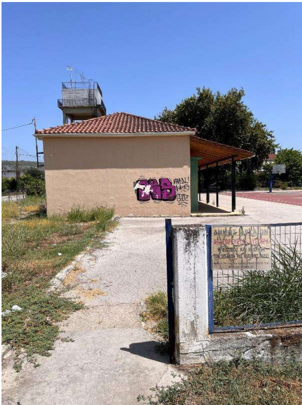
Εικόνα 247: Δευτερεύουσα είσοδος (Δημοτικό Σχολείο Κεραματών – Κωδικός θέσης: Δ.Κ._33)
