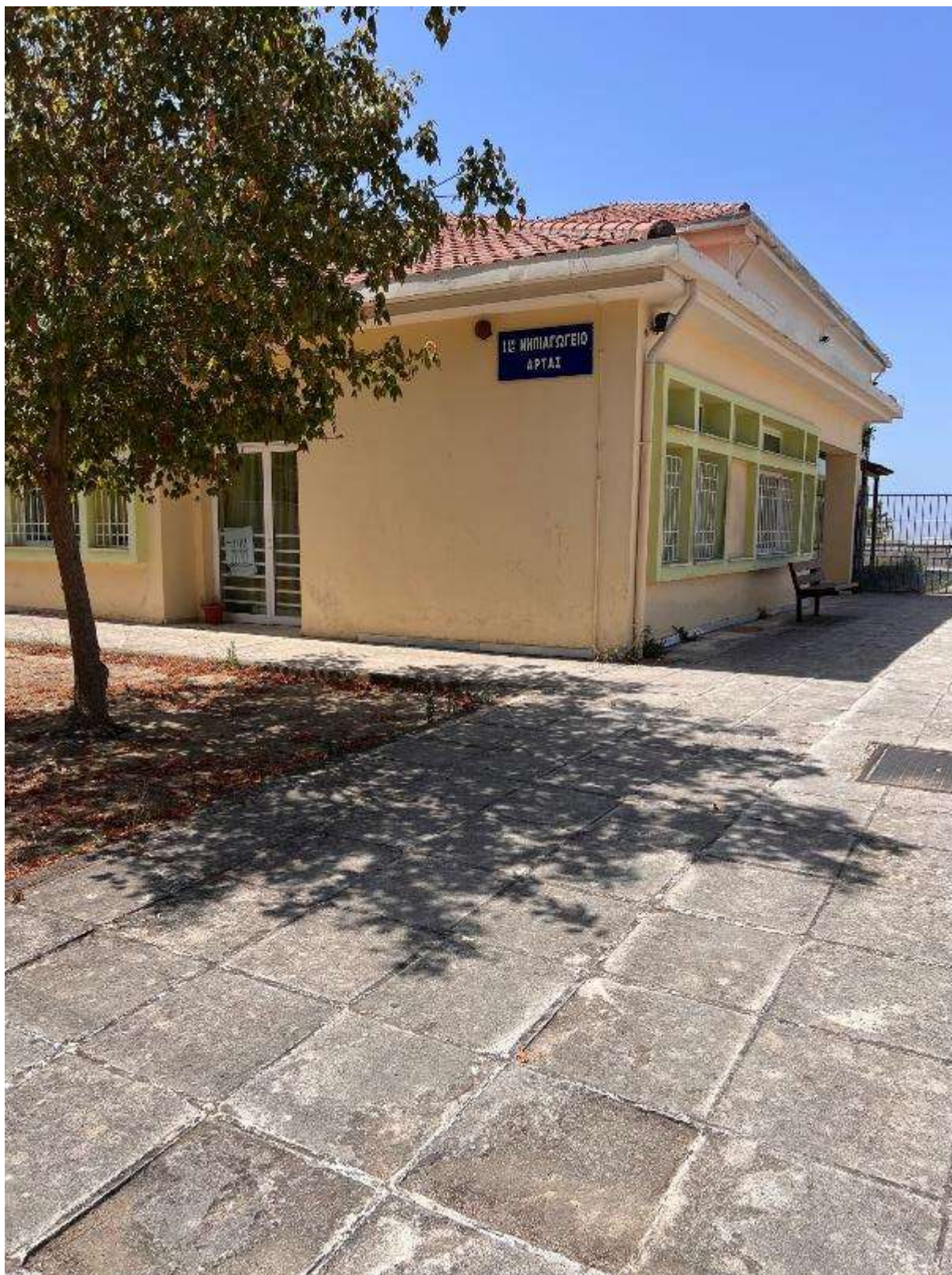
Εικόνα 192: Όψη κτιρίου (11 ο Νηπιαγωγείο Άρτας – Κωδικός θέσης: Δ.Κ._17)
