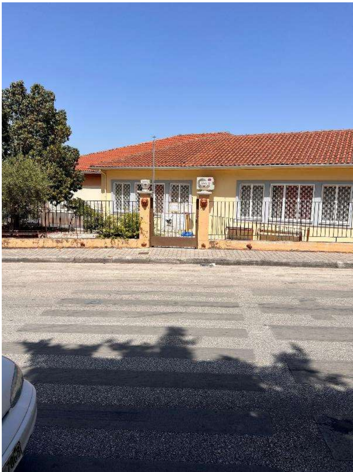
Εικόνα 193: Κεντρική είσοδος (12 ο Νηπιαγωγείο Άρτας – Κωδικός θέσης: Δ.Κ._18)
