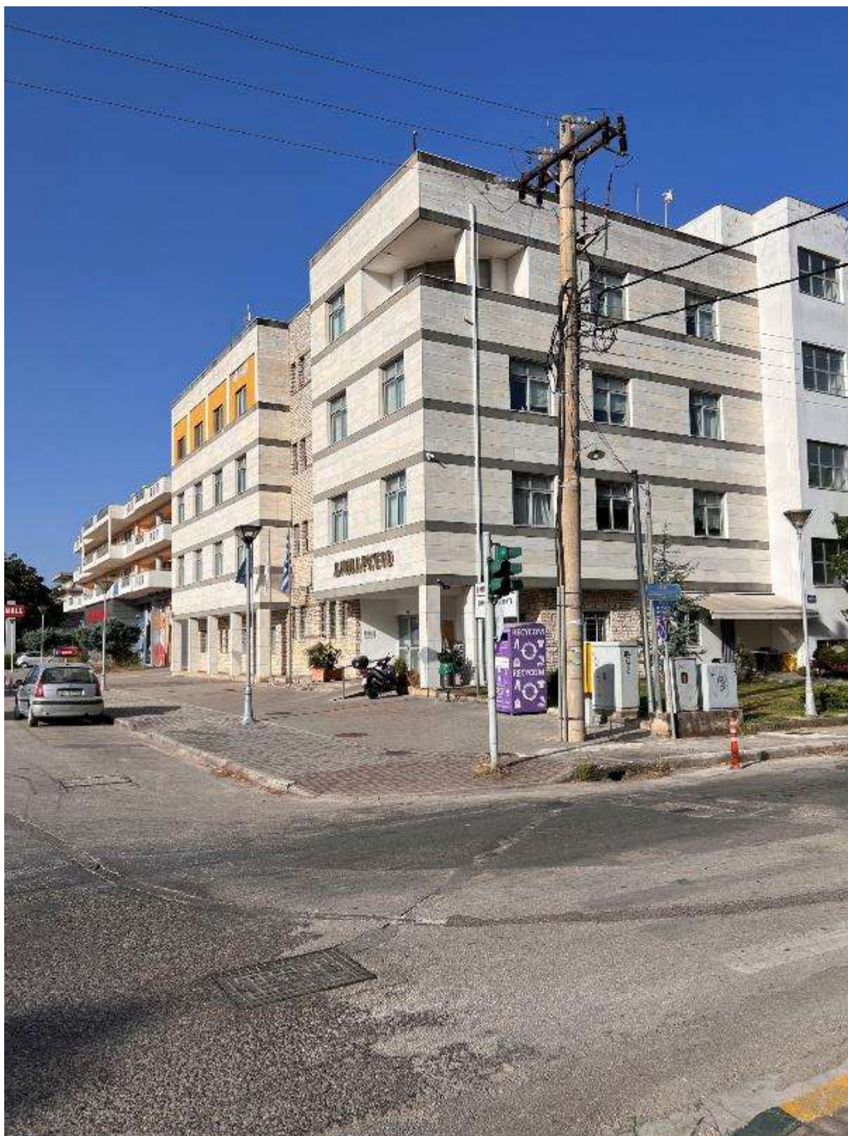
Εικόνα 145: Γενική άποψη κτιρίου – πρόσοψη από περιφερειακή Άρτας (Δημαρχείο Άρτας – Κωδικός θέσης: Δ.Κ._1)
