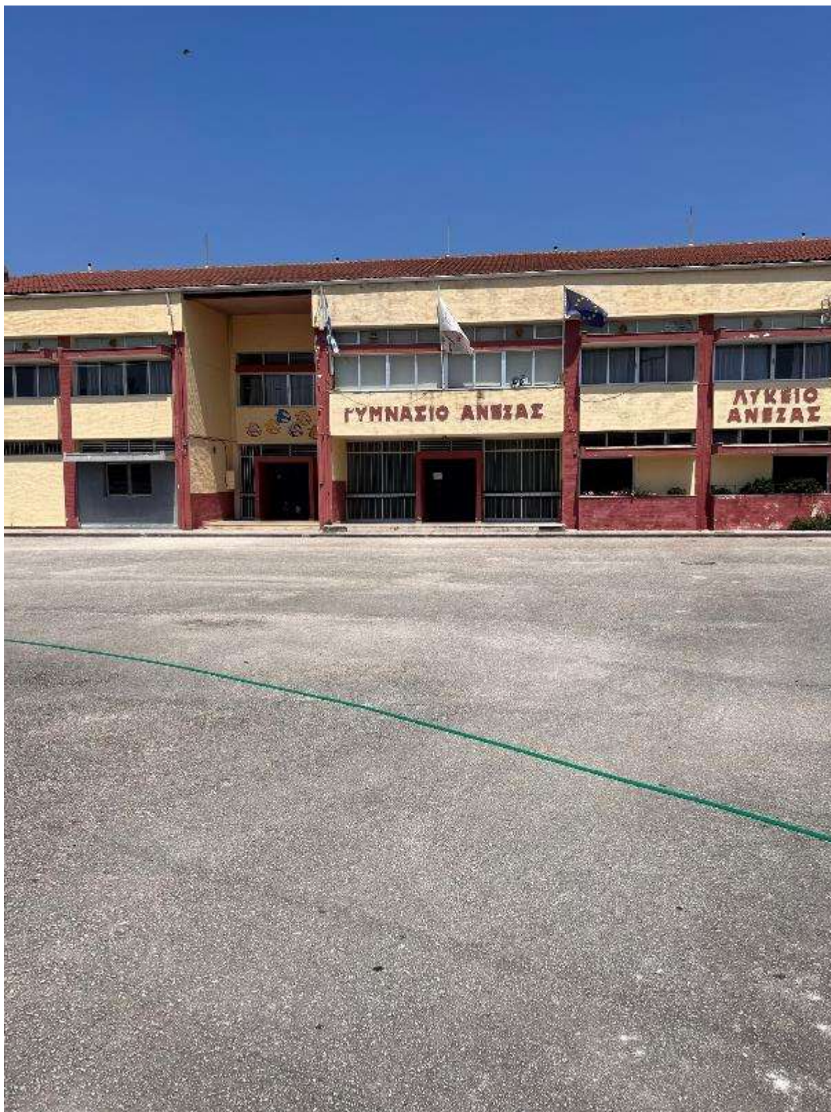
Εικόνα 278: Όψη 2 (Γυμνάσιο & Λύκειο Ανέζας – Κωδικός θέσης: Δ.Κ._45)
