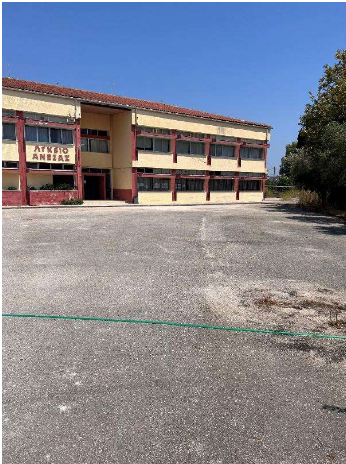
Εικόνα 277: Όψη 1 (Γυμνάσιο & Λύκειο Ανέζας – Κωδικός θέσης: Δ.Κ._45)
