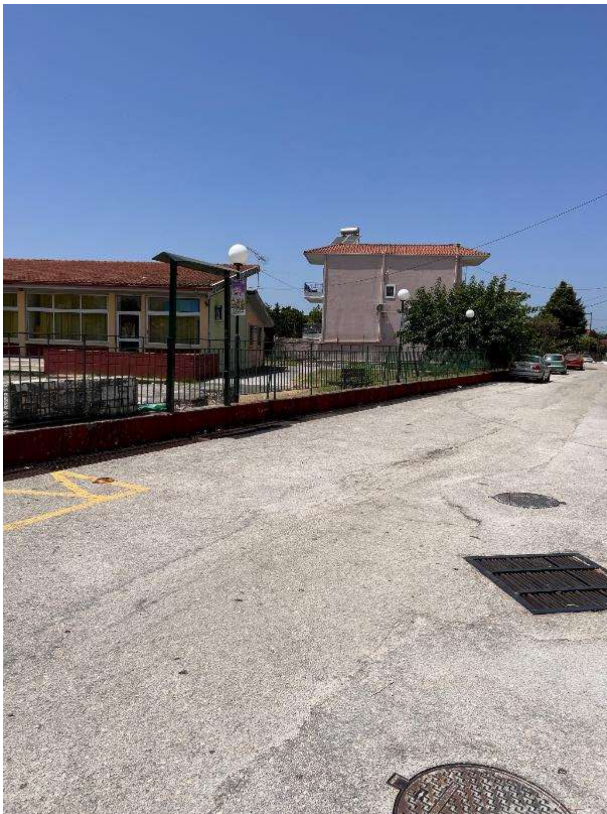
Εικόνα 249: Πλάγια όψη (Νηπιαγωγείο & Δημοτικό Σχολείο Κωστακιών – Κωδικός θέσης: Δ.Κ._34)
