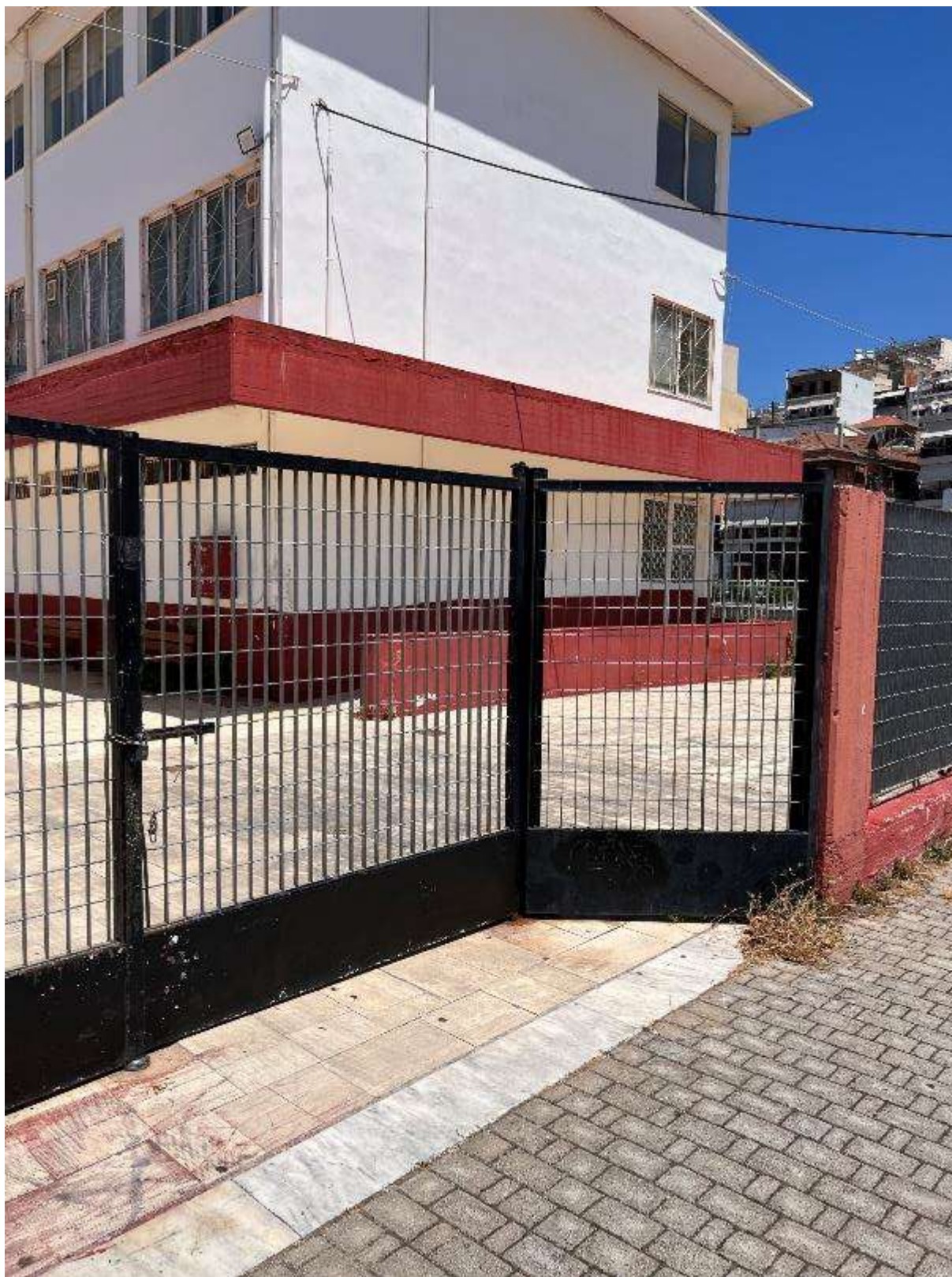
Εικόνα 221: Όψη κεντρικής εισόδου (2 ο Γυμνάσιο & 2 ο ΓΕ.Λ Αρτας – Κωδικός θέσης: Δ.Κ._25)
