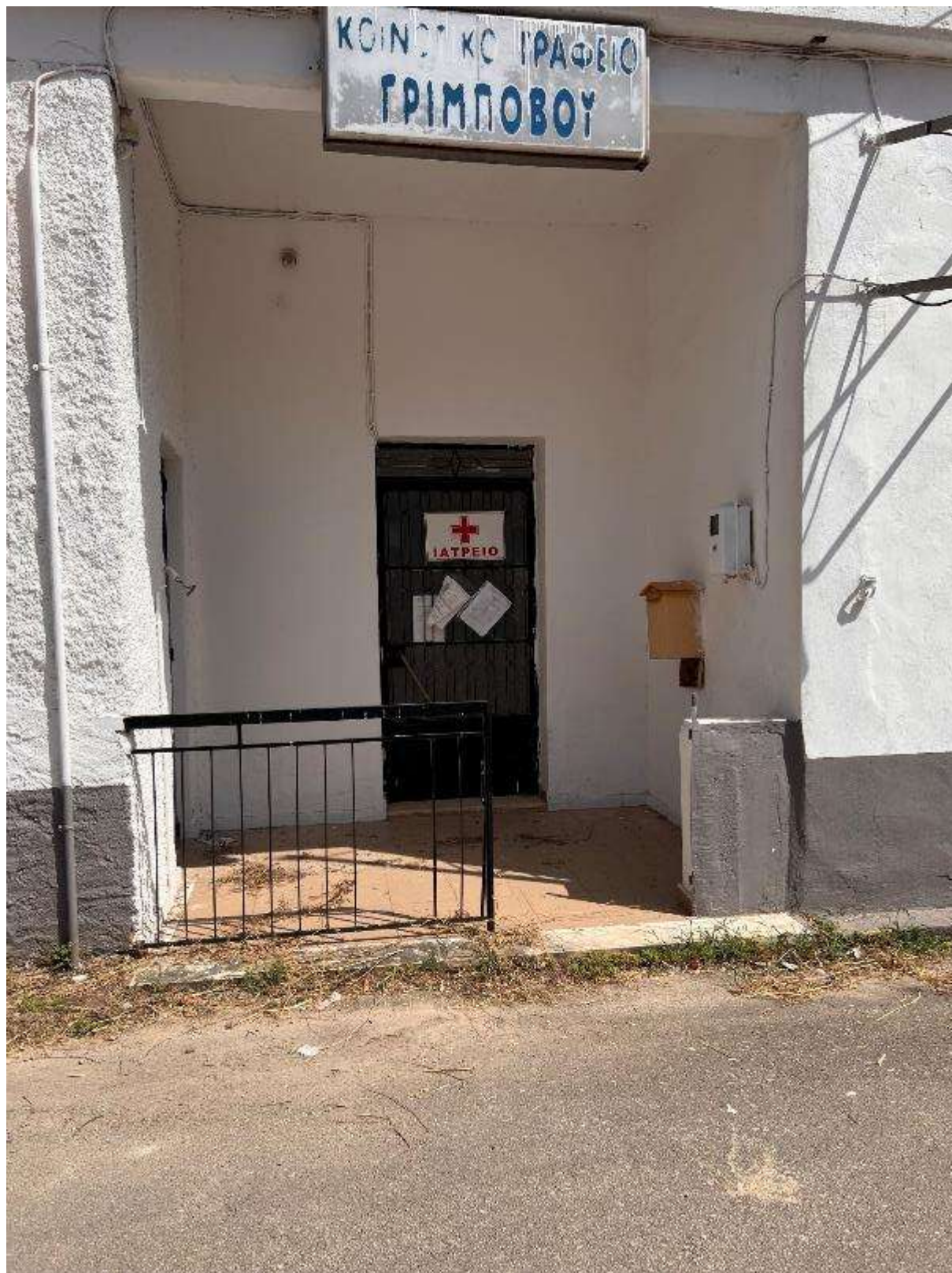
Εικόνα 262: Κεντρική είσοδος (Κοινοτικό Κατάστημα Γκριμπόβου – Κωδικός θέσης: Κ.Χ._39)
