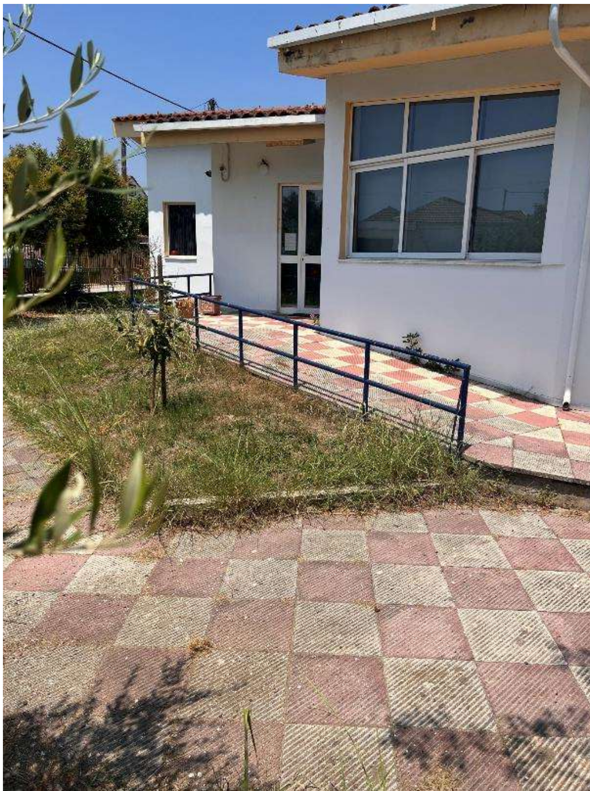
Εικόνα 303: Όψη 3 (Νηπιαγωγείο & Δημοτικό Σχολείο Καλόβατου – Κωδικός θέσης: Δ.Κ._54)
