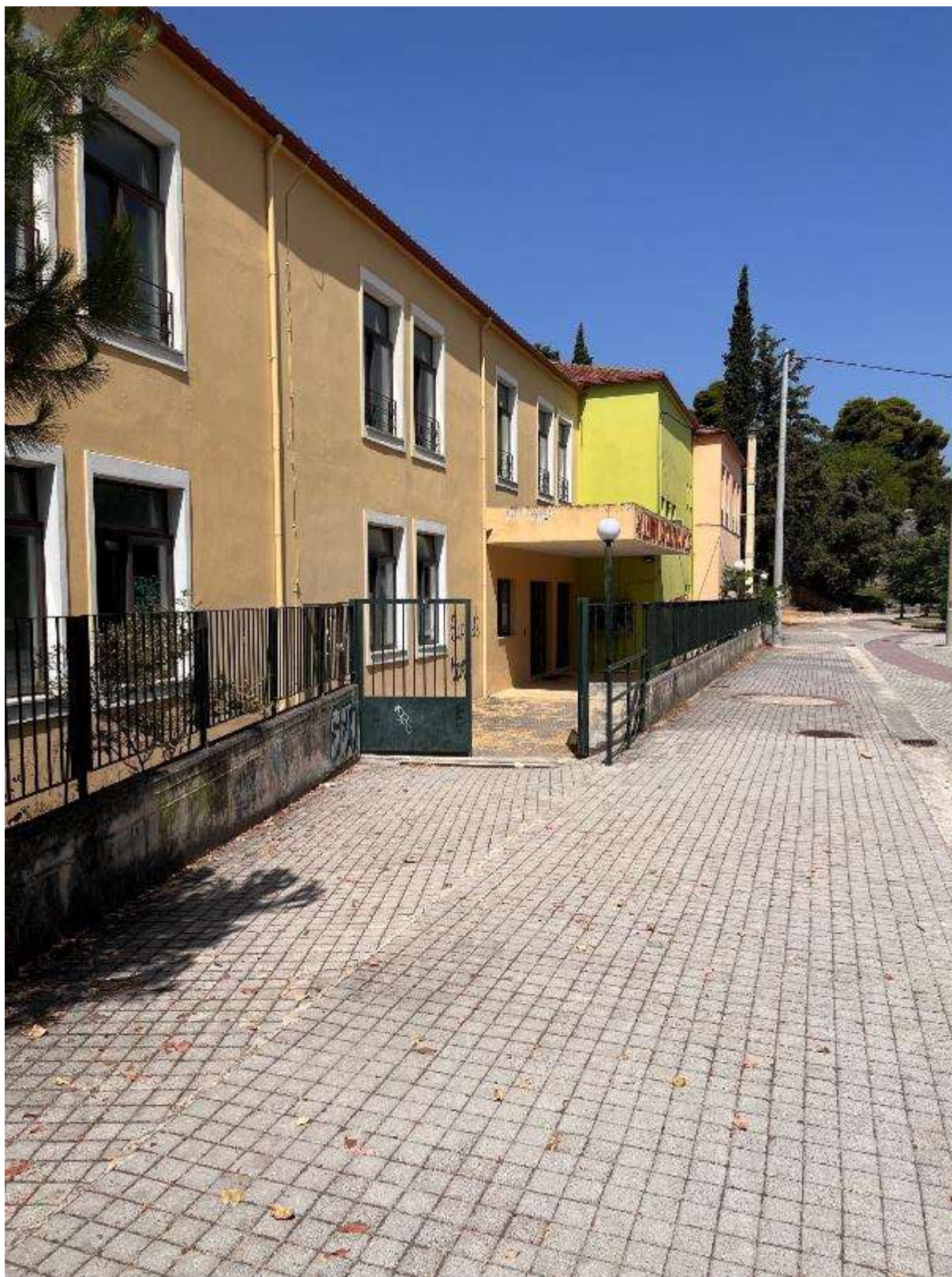
Εικόνα 176: Κεντρική είσοδος Δημοτικού (4 ο Νηπιαγωγείο & 4 ο Δημοτικό Σχολείο Άρτας – Κωδικός θέσης: Δ.Κ._11)
