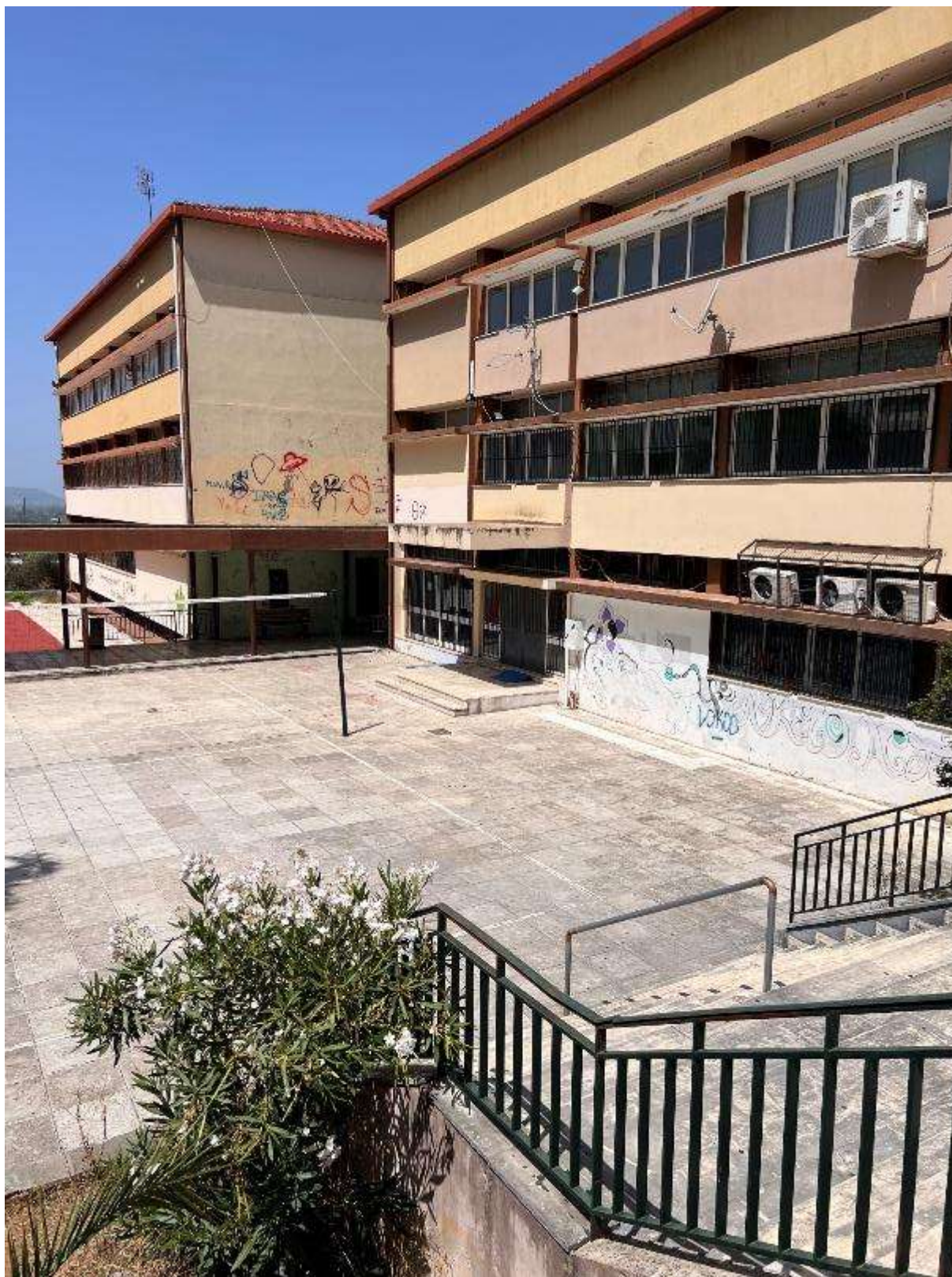
Εικόνα 229: Όψη 2 (4 ο Γυμνάσιο & 4 ο Γ.Ε.Λ Αρτας – Κωδικός θέσης: Δ.Κ._27)
