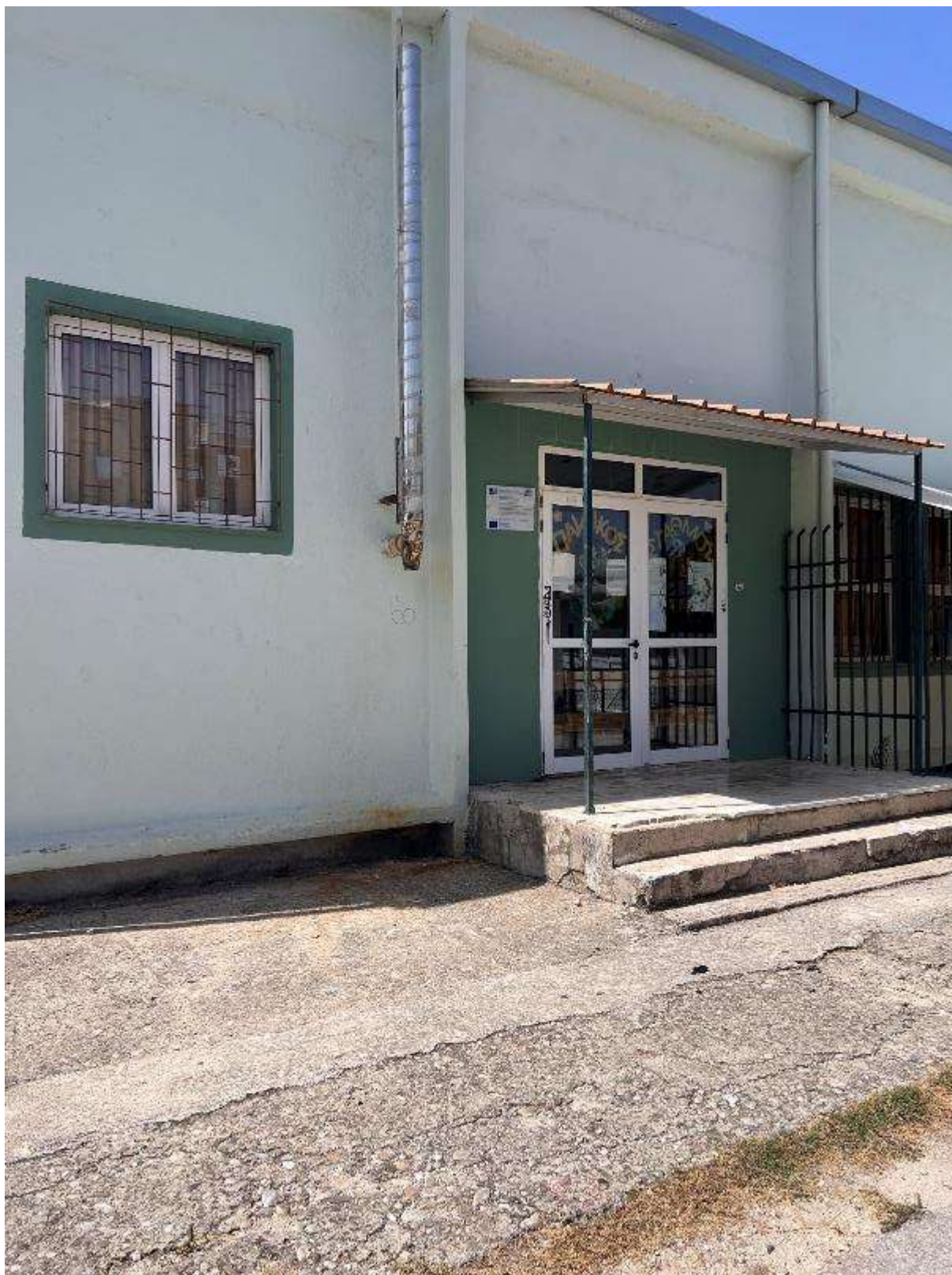
Εικόνα 320: Πλάγια όψη (Νηπιαγωγείο Αγίων Αναργύρων – Κωδικός θέσης: Δ.Κ._60)
