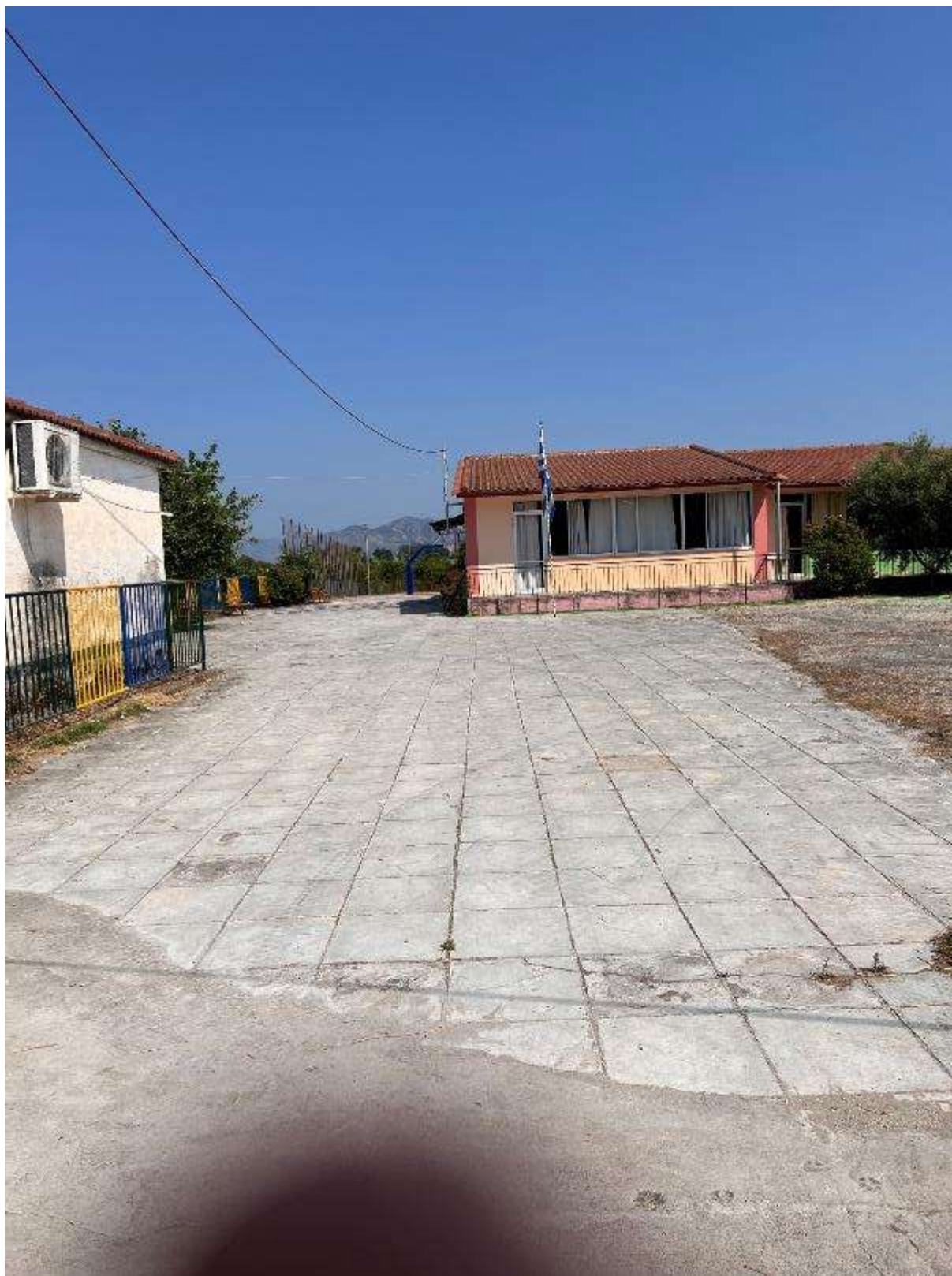
Εικόνα 293: Όψη 1 (Νηπιαγωγείο & Δημοτικό Σχολείο Ράχης – Κωδικός θέσης: Δ.Κ._51)
