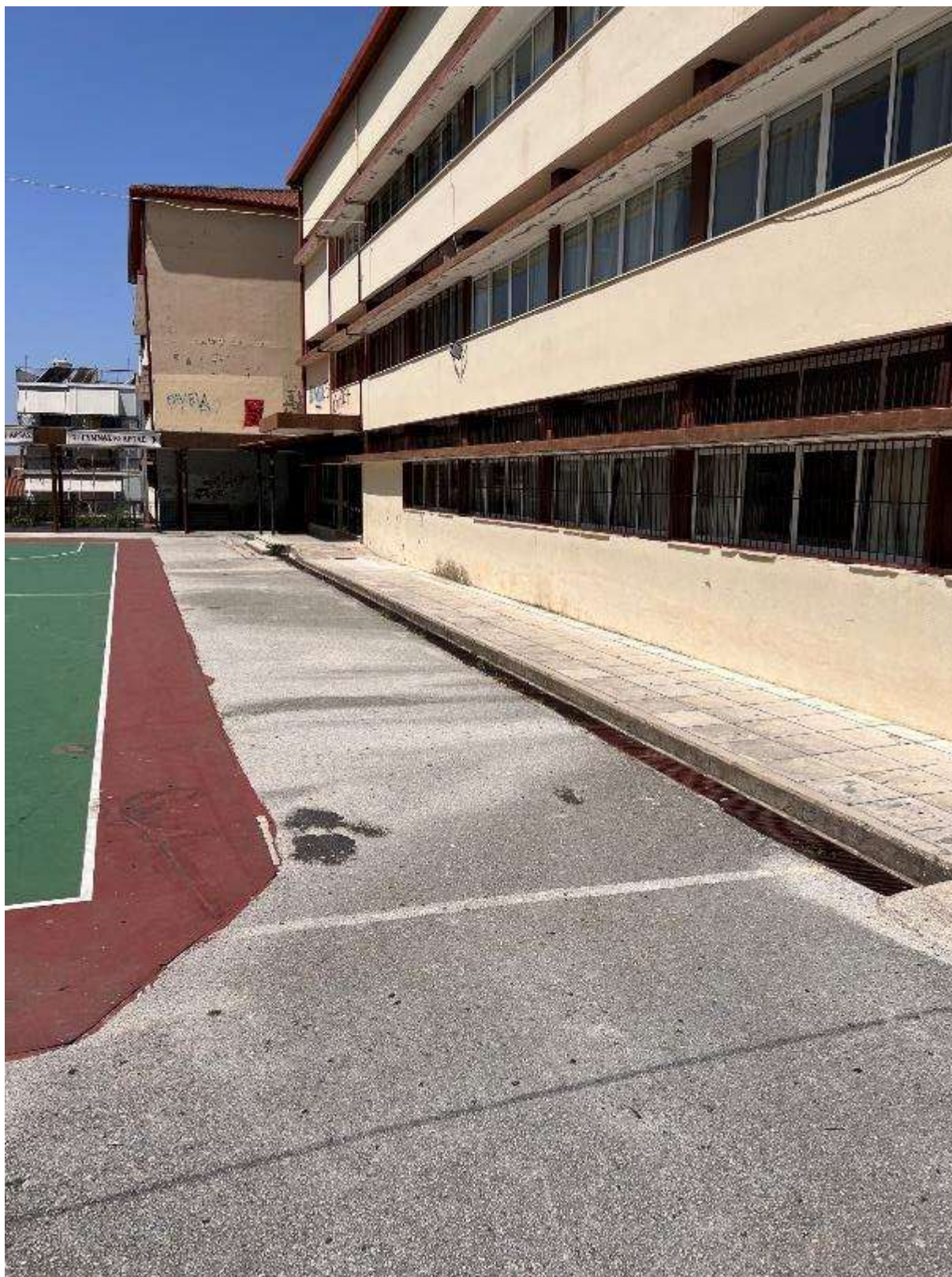
Εικόνα 230: Όψη 3 (4 ο Γυμνάσιο & 4 ο Γ.Ε.Λ Αρτας – Κωδικός θέσης: Δ.Κ._27)
