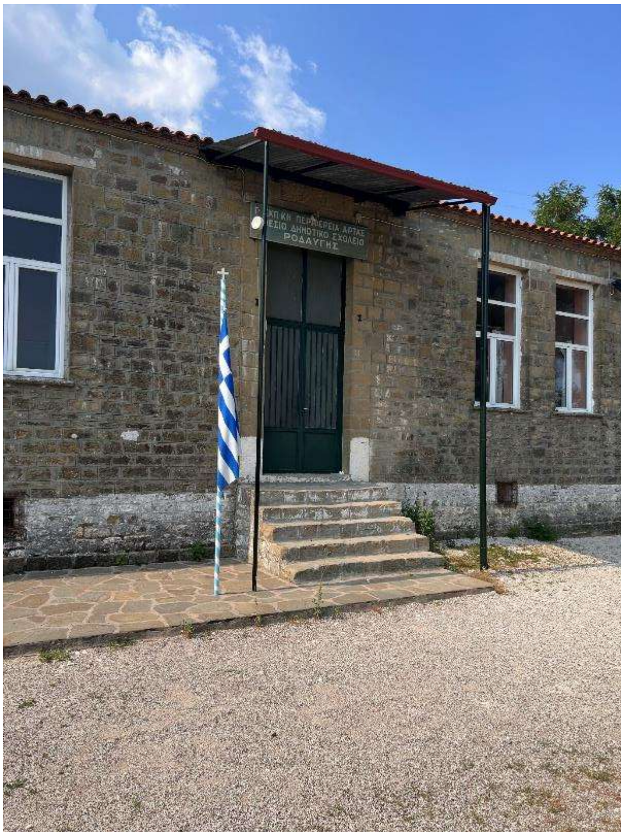
Εικόνα 319: Κεντρική είσοδος (Δημοτικό Σχολείο Ροδαυγής – Κωδικός θέσης: Δ.Κ._59)
