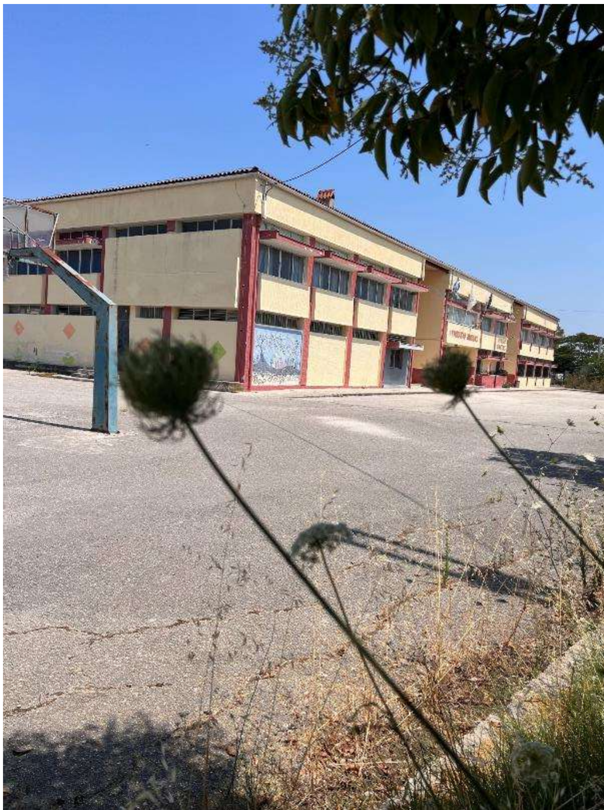
Εικόνα 279: Πλάγια όψη (Γυμνάσιο & Λύκειο Ανέζας – Κωδικός θέσης: Δ.Κ._45)
