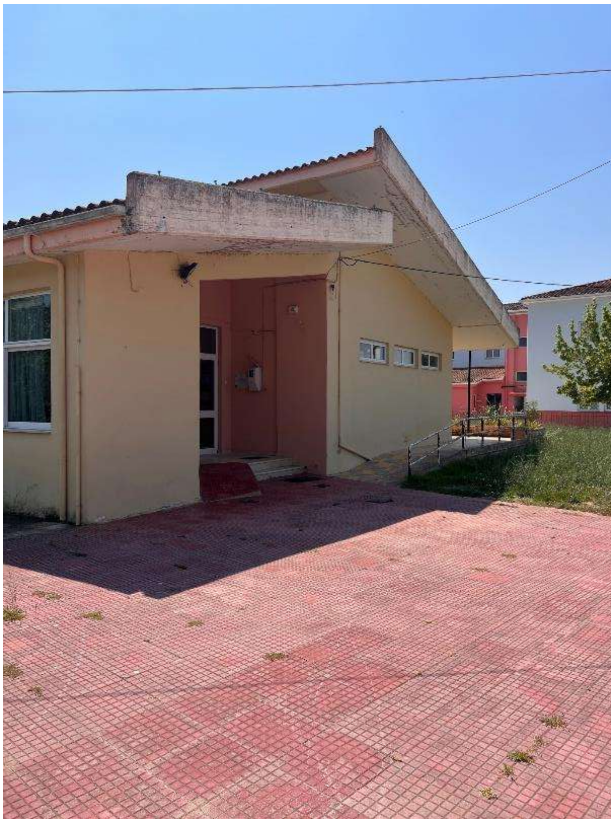
Εικόνα 272: Κεντρική είσοδος (Νηπιαγωγείο Ανέζας – Κωδικός θέσης: Δ.Κ._43)
