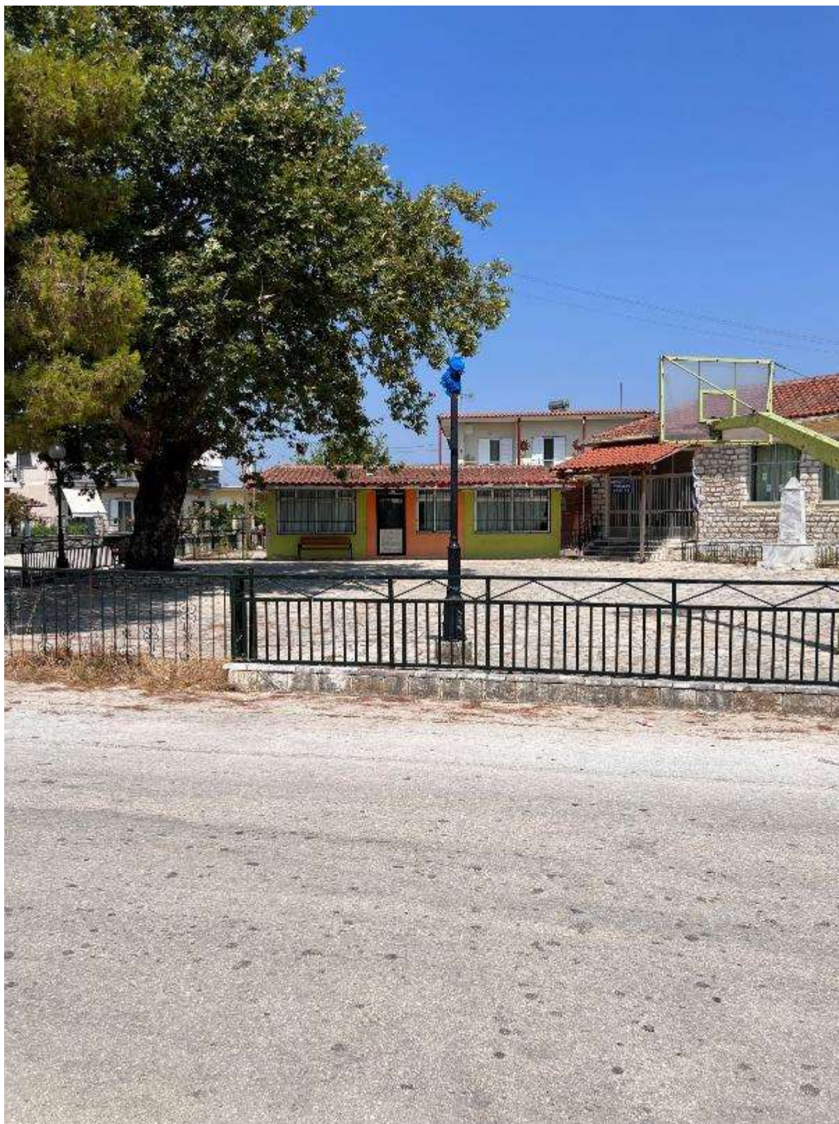
Εικόνα 283: Όψη 1 (Δημοτικό Σχολείο Γαβριάς – Κωδικός θέσης: Κ.Χ._47)
