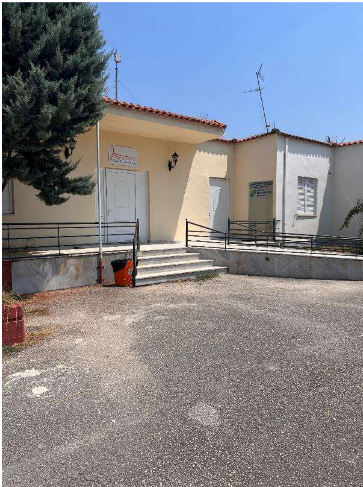
Εικόνα 325: Όψη 1 (Κτίριο Κ.Ε.Π Φιλοθέης – Κωδικός θέσης: Κ.Χ._62)
