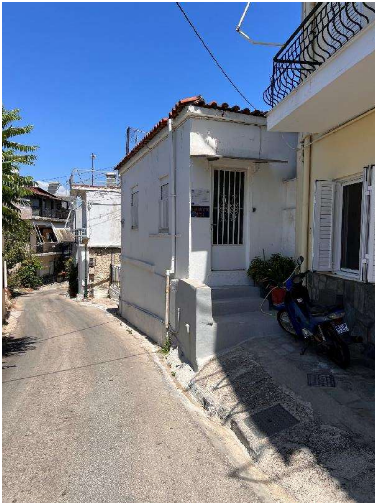
Εικόνα 167: Κεντρική είσοδος (1 ο Νηπιαγωγείο Άρτας – Κωδικός θέσης: Δ.Κ. 8)
