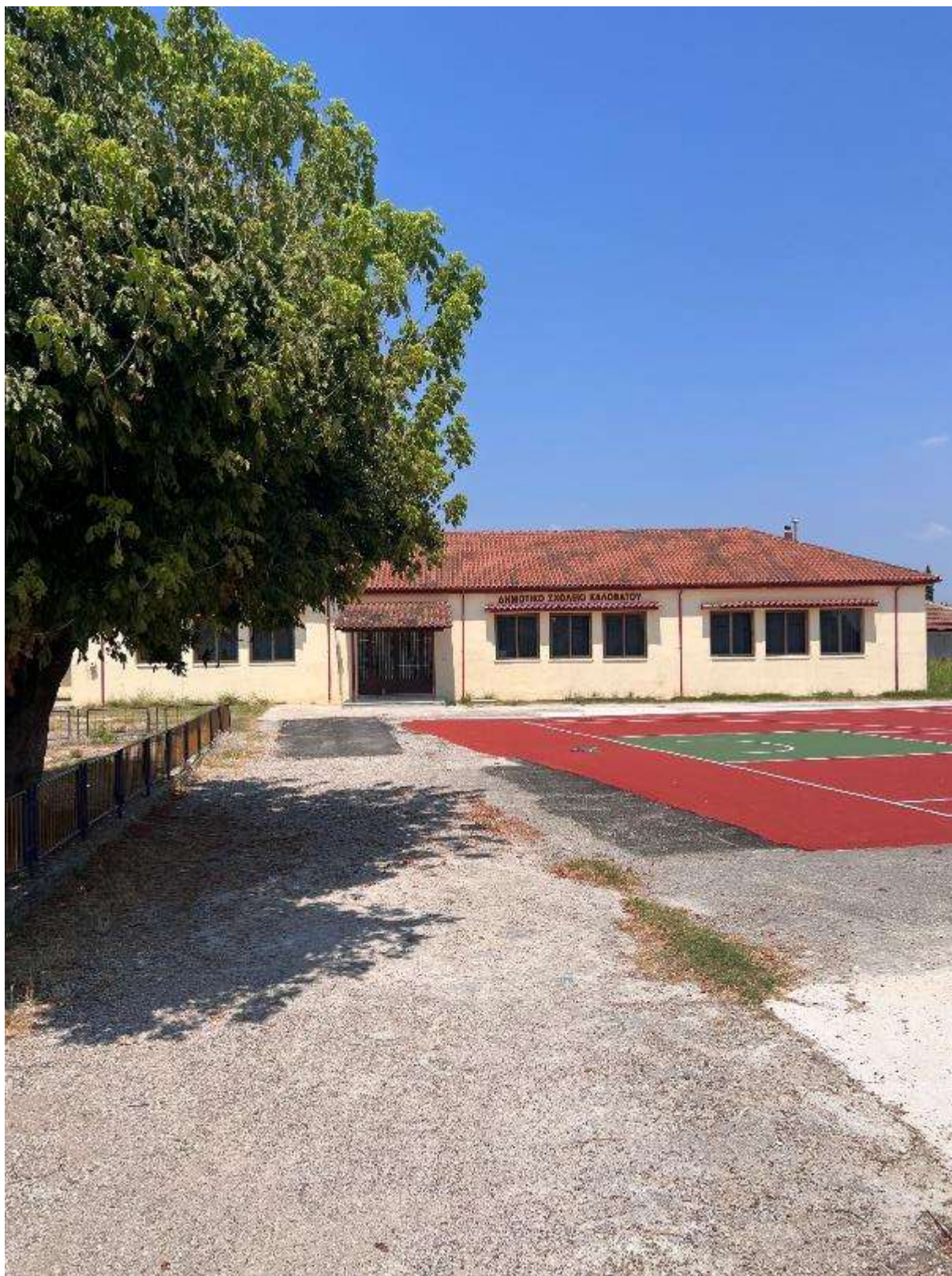
Εικόνα 301: Όψη 1 (Νηπιαγωγείο & Δημοτικό Σχολείο Καλόβατου – Κωδικός θέσης: Δ.Κ._54)
