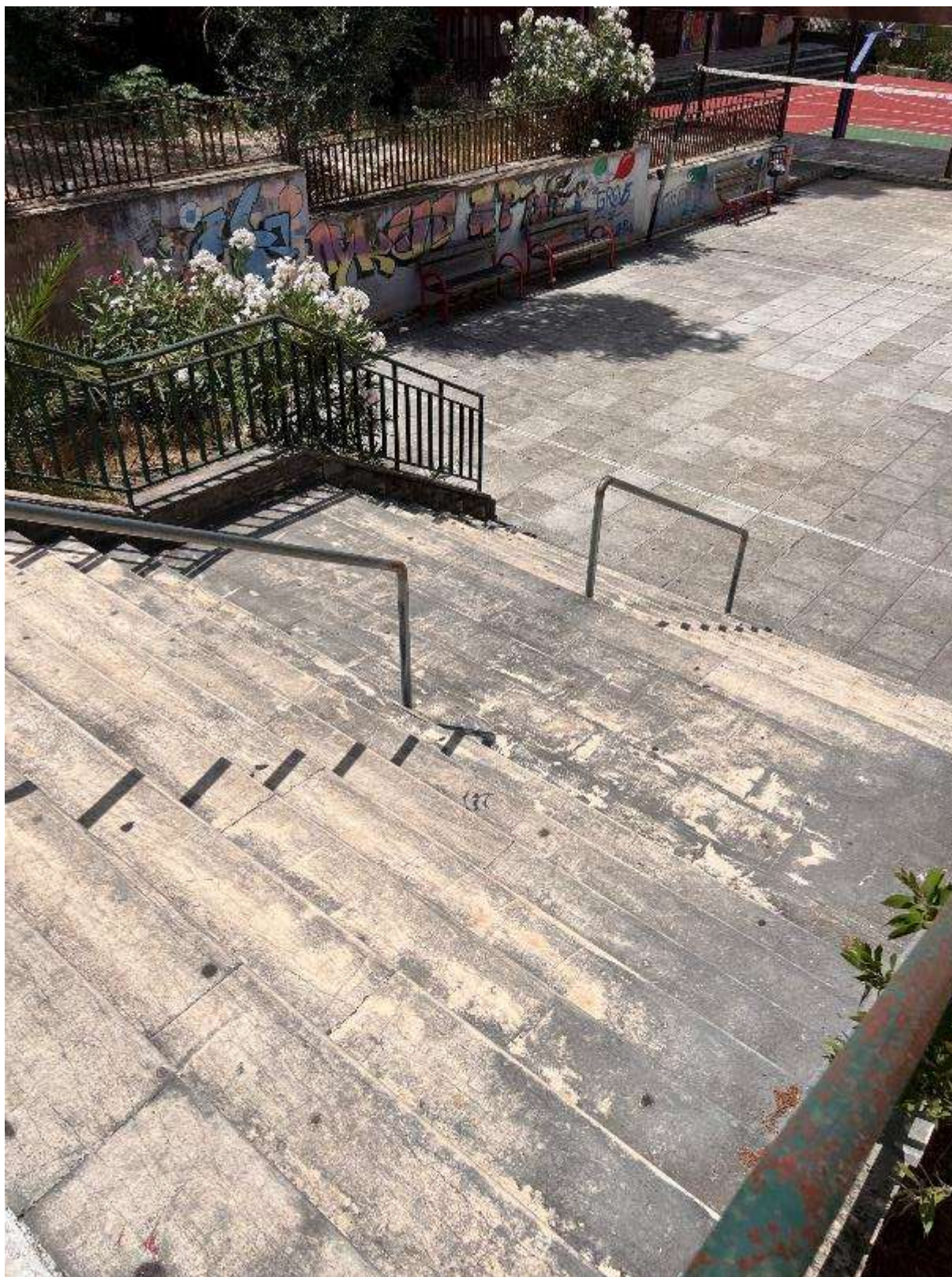
Εικόνα 228: Όψη 1 (4 ο Γυμνάσιο & 4 ο Γ.Ε.Λ Αρτας – Κωδικός θέσης: Δ.Κ._27)
