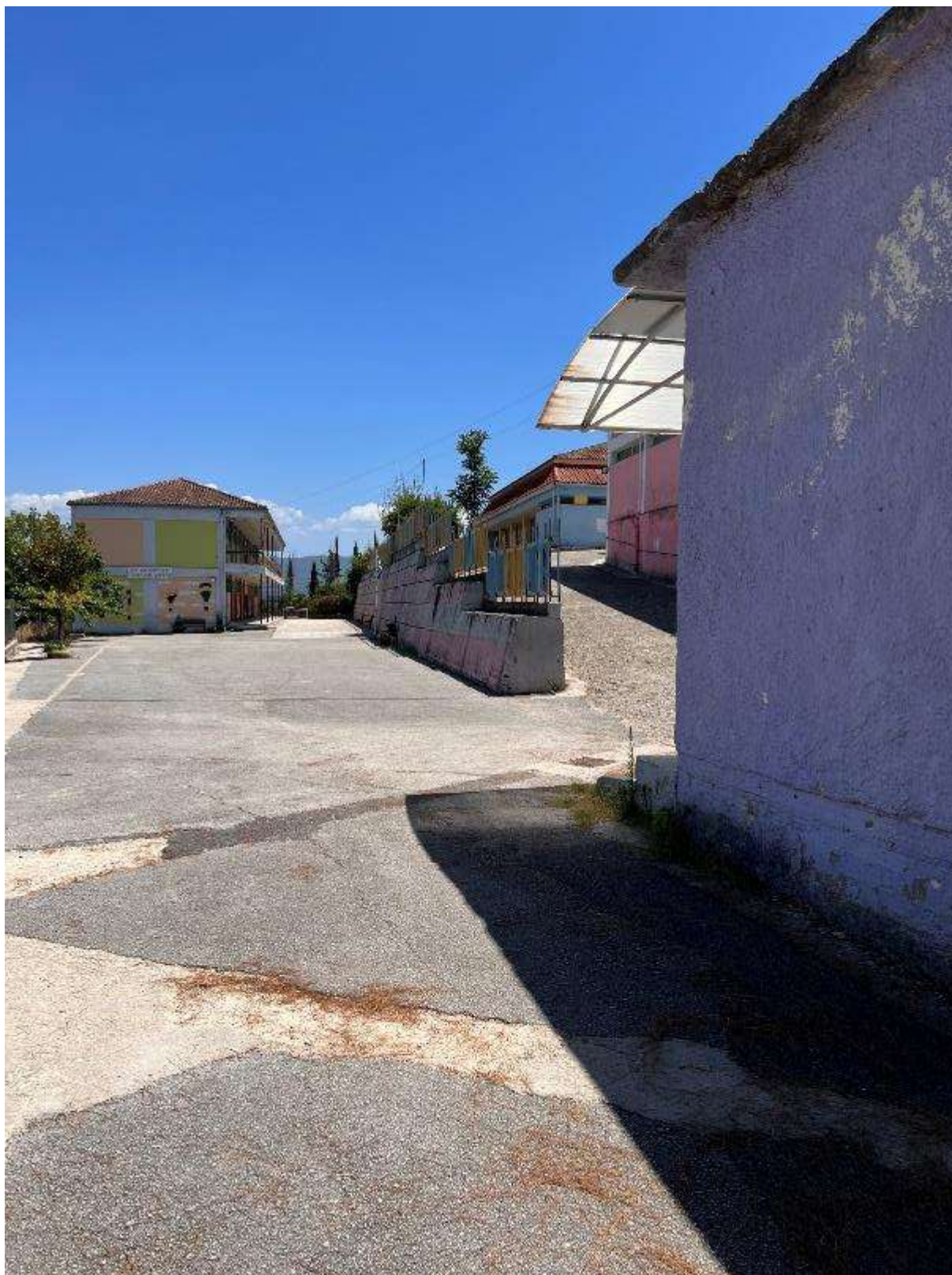
Εικόνα 185: Όψη 2 (8 ο Νηπιαγωγείο & 6 ο Δημοτικό Σχολείο Αρτας – Κωδικός θέσης: Δ.Κ._14)
