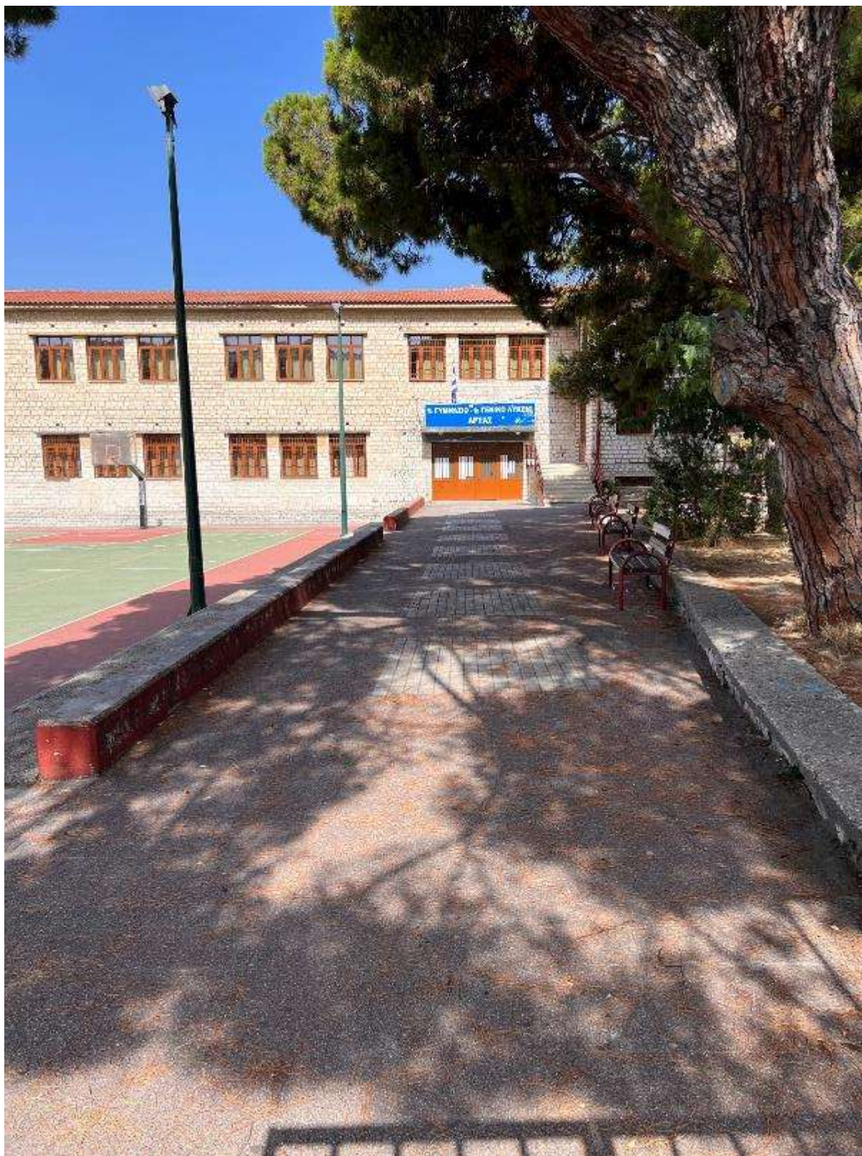
Εικόνα 196: Κεντρική είσοδος Γυμνασίου-Λυκείου (1 ο Δημοτικό Σχολείο & 1 ο Γυμνάσιο & 1 ο ΓΕ.Λ Αρτας – Κωδικός θέσης: Δ.Κ._19)
