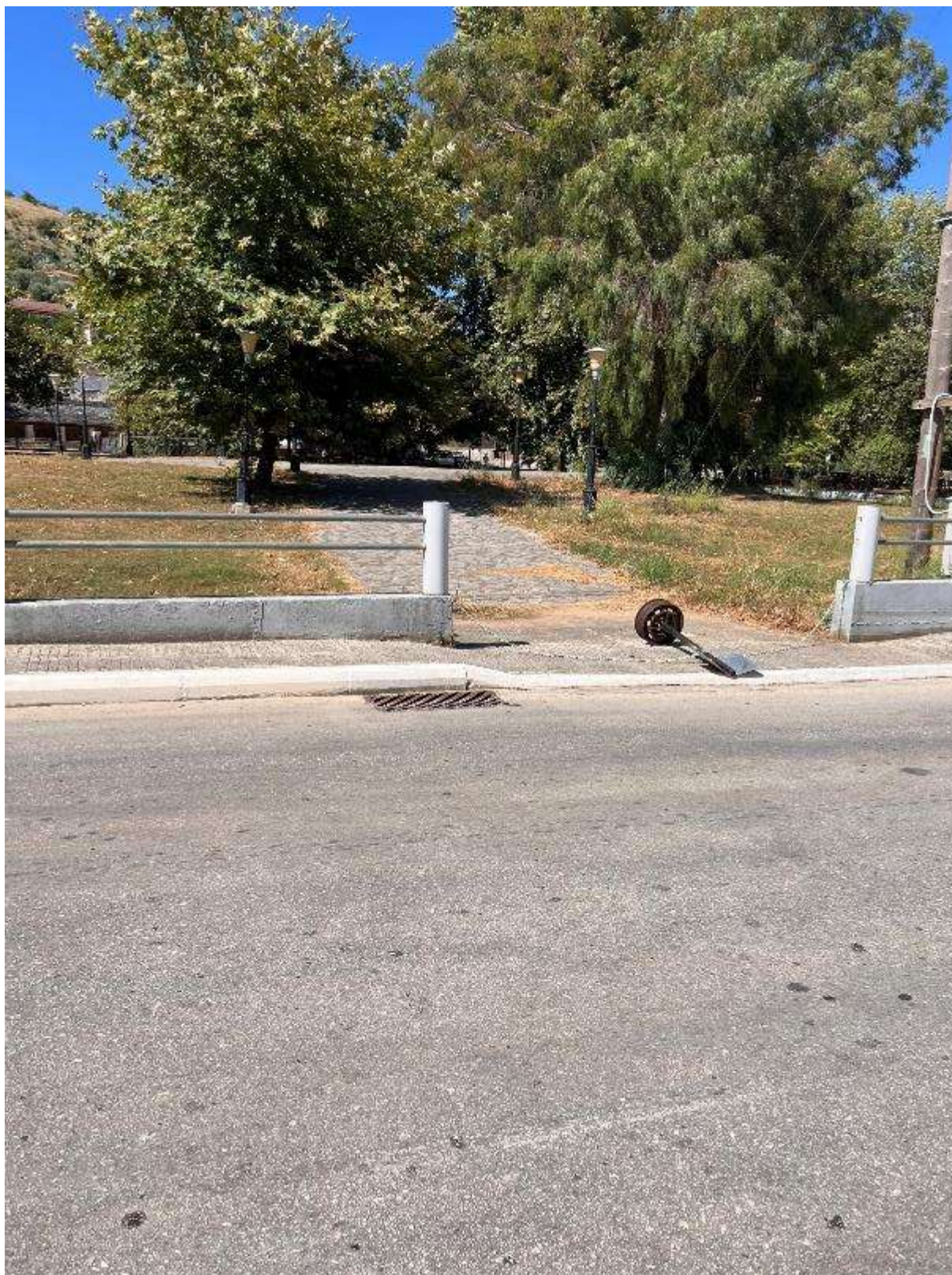
Εικόνα 132: Νότια πλευρά πλατείας – διαμορφωμένη ράμπα εισόδου (Πλατεία Καμπής – Κωδικός θέσης: Κ.Χ._32)
