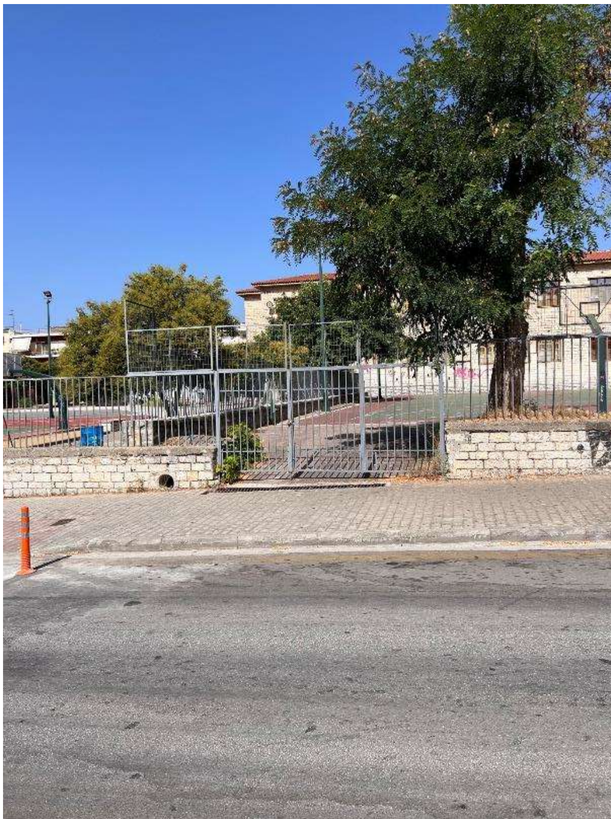
Εικόνα 197: Δευτερεύουσα είσοδος Γυμνασίου-Λυκείου (1 ο Δημοτικό Σχολείο & 1 ο Γυμνάσιο & 1 ο ΓΕ.Λ Αρτας – Κωδικός θέσης: Δ.Κ._19)
