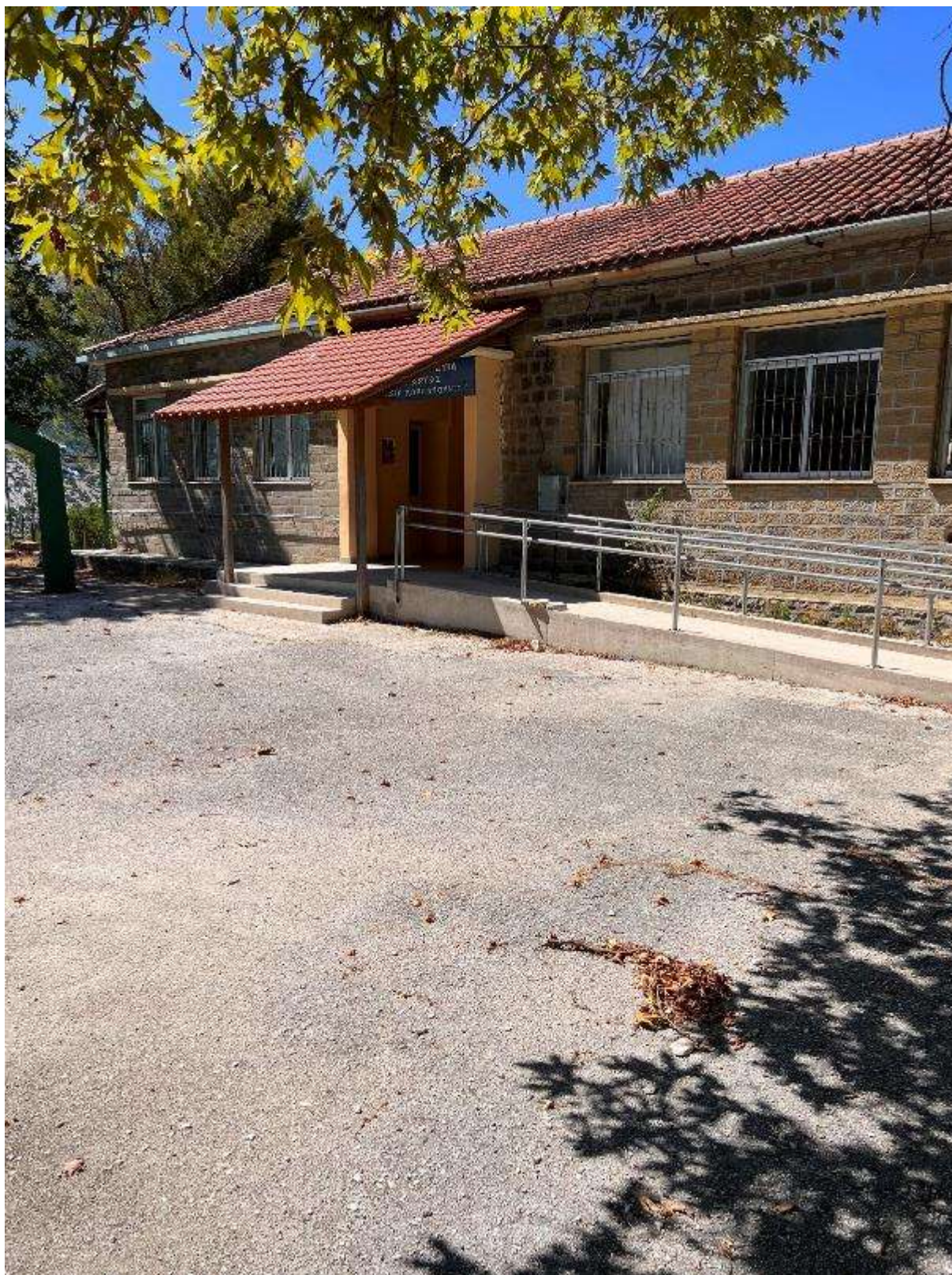
Εικόνα 268: Πλάγια όψη (Δημοτικό Σχολείο Κορφοβουνίου – Κωδικός θέσης: Κ.Χ._41)
