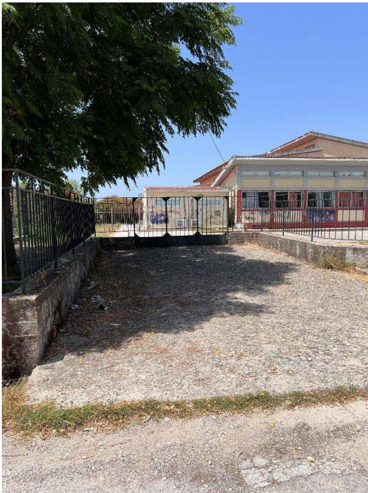
Εικόνα 248: Κεντρική είσοδος (Νηπιαγωγείο & Δημοτικό Σχολείο Κωστακίων – Κωδικός θέσης: Δ.Κ._34)
