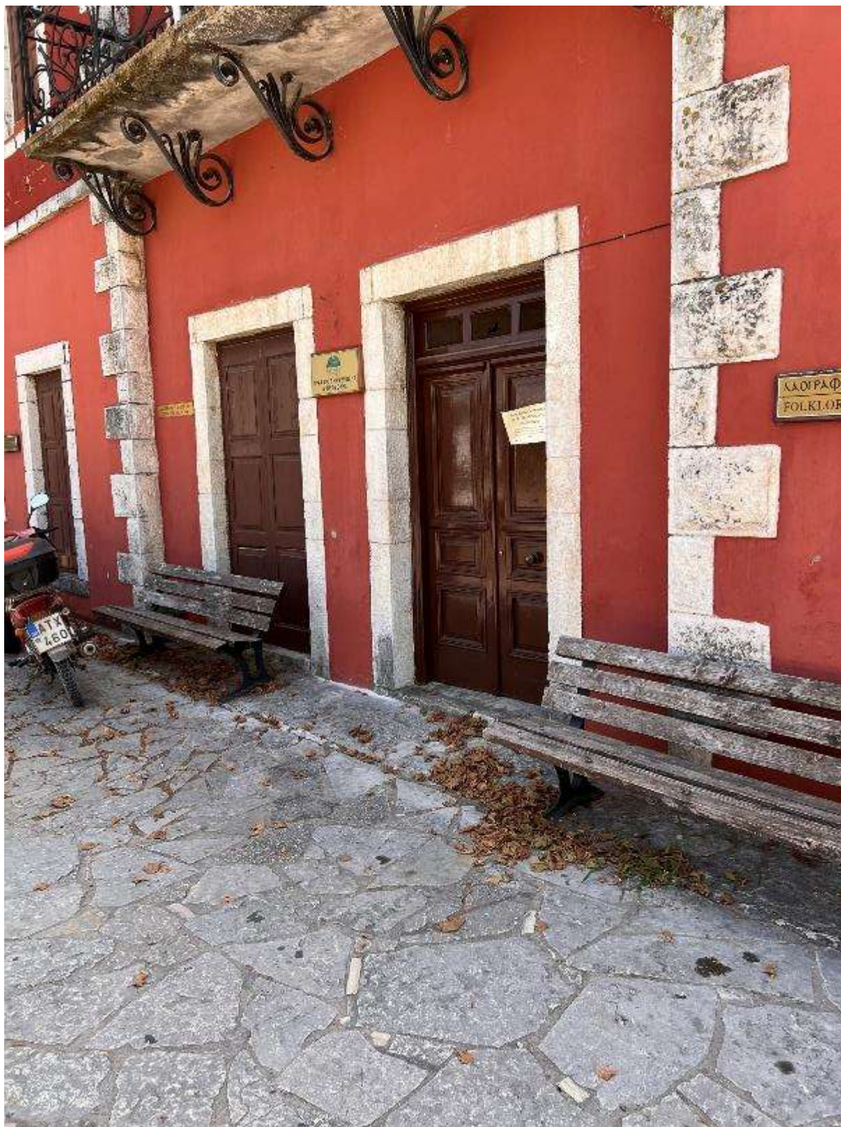
Εικόνα 155: Είσοδος πίσω όψης κτιρίου (Λαογραφικό Μουσείο Αρτας – Κωδικός θέσης: Δ.Κ._3)
