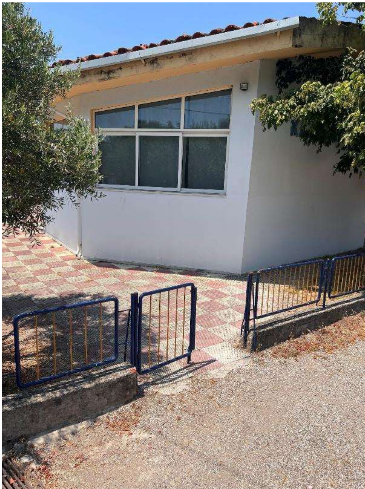
Εικόνα 302: Όψη 2 (Νηπιαγωγείο & Δημοτικό Σχολείο Καλόβατου – Κωδικός θέσης: Δ.Κ._54)
