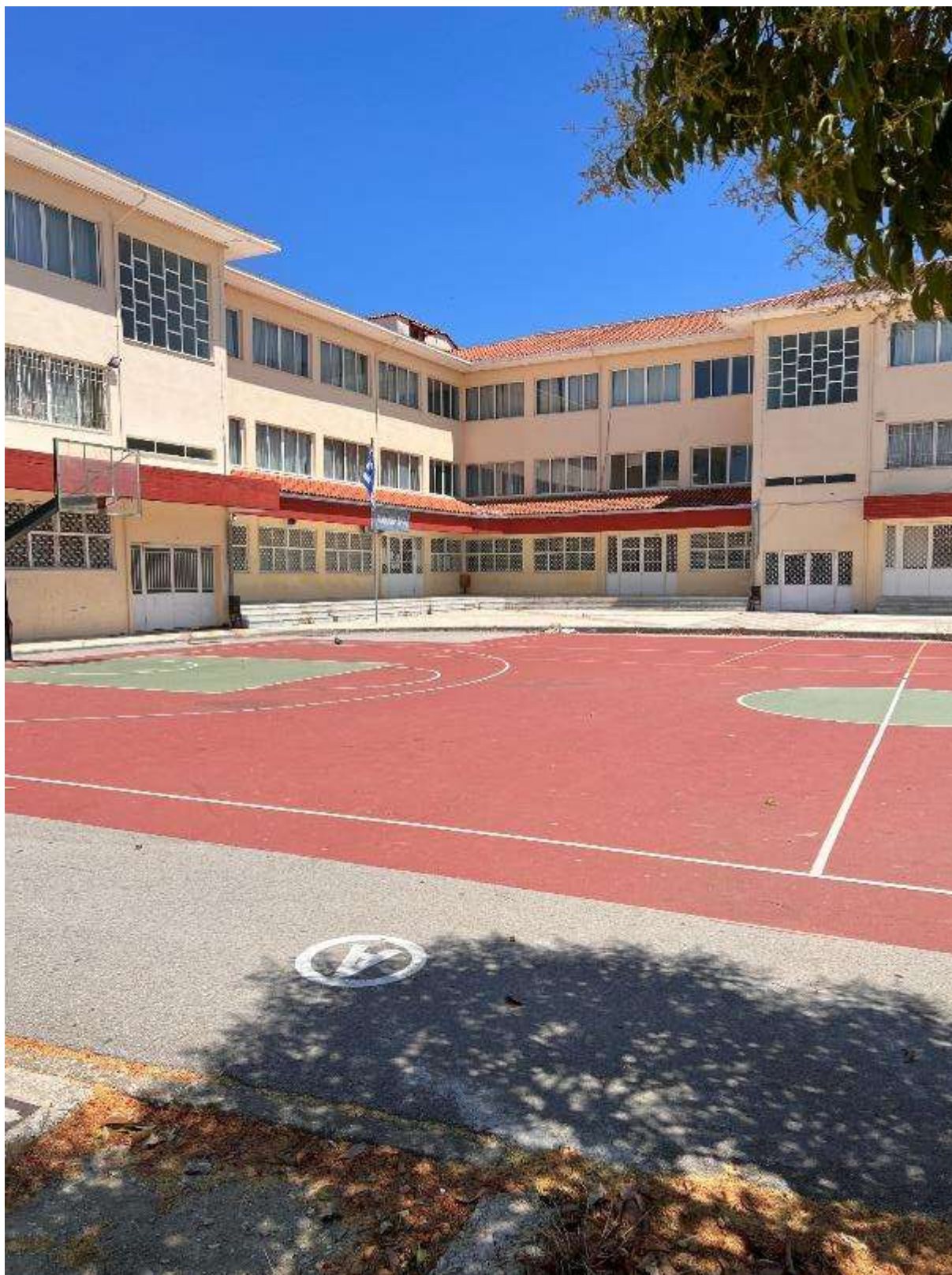
Εικόνα 216: Όψη προαύλιου χώρου (2 ο Γυμνάσιο & 2 ο ΓΕ.Λ Αρτας – Κωδικός θέσης: Δ.Κ._25)
