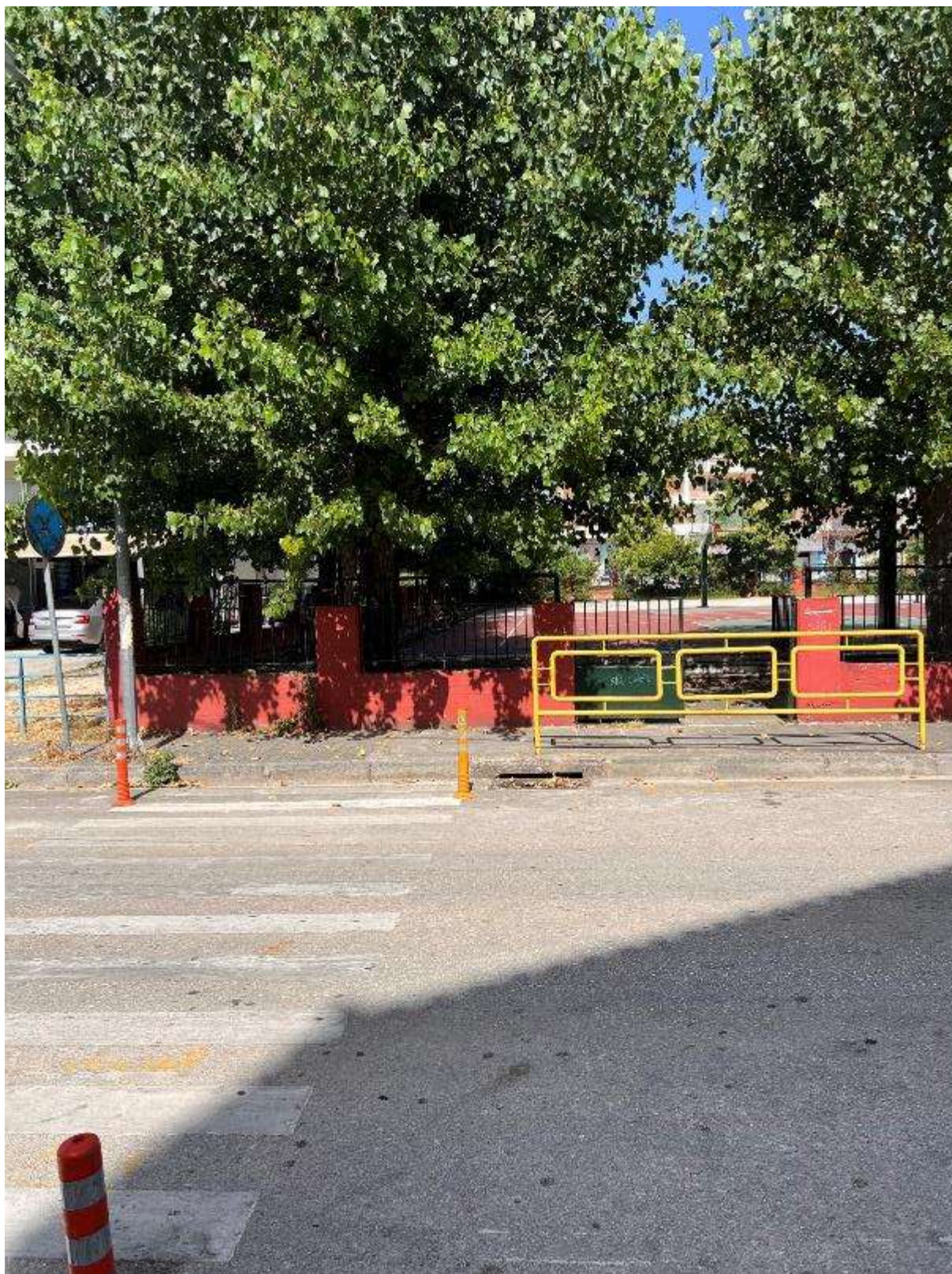
Εικόνα 210: Δευτερεύουσα είσοδος κτιρίου (8 ο Δημοτικό Σχολείο Άρτας – Κωδικός θέσης: Δ.Κ._23)
