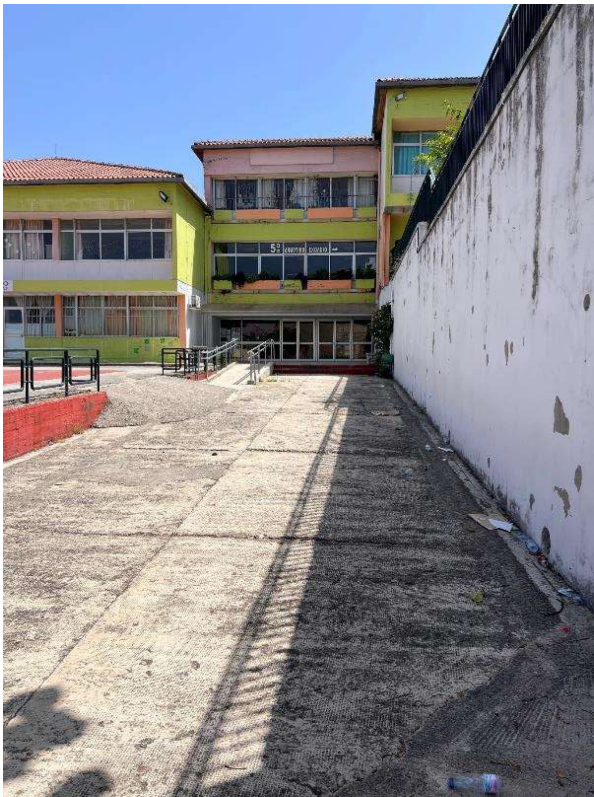
Εικόνα 204: Κεντρική είσοδος 5 ου Δημοτικού (3 ο Δημοτικό Σχολείο & 5 ο Δημοτικό Σχολείο Αρτας – Κωδικός θέσης: Δ.Κ._21)
