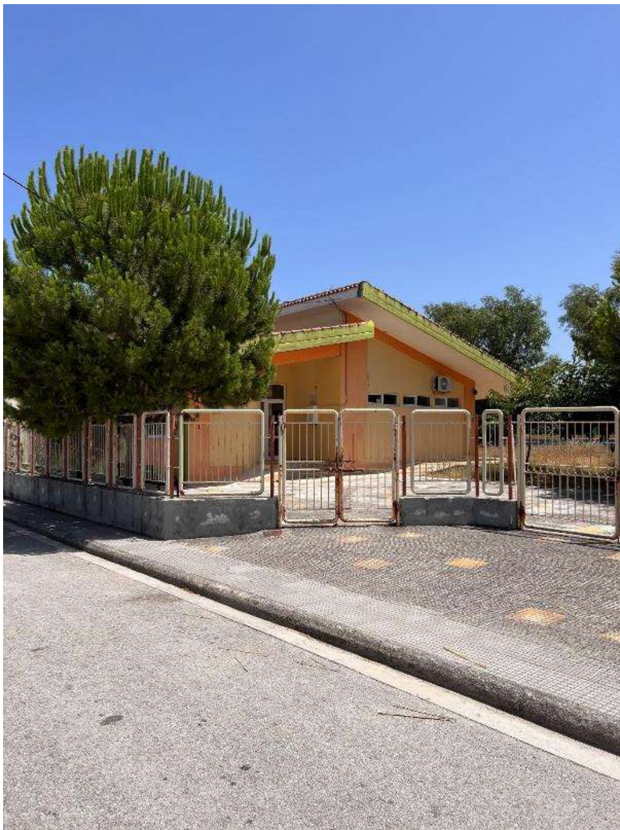
Εικόνα 241: Κεντρική είσοδος Νηπιαγωγείου (Νηπιαγωγείο Ελεούσας – Κωδικός θέσης: Δ.Κ._31)
