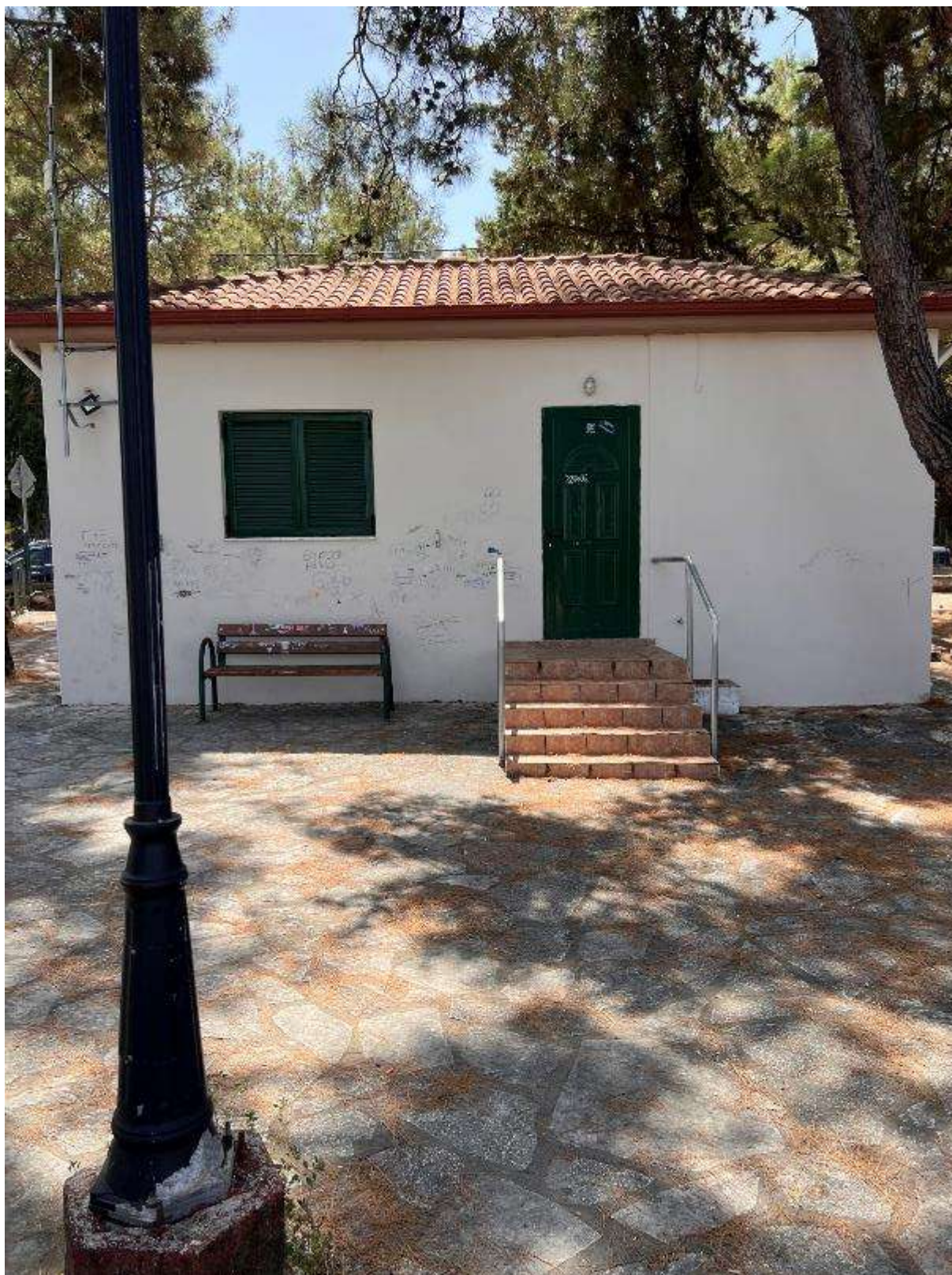
Εικόνα 166: Είσοδος κτιρίου (Κ.Α.Π.Η. άνω πόλης – Κωδικός θέσης: Δ.Κ._7)
