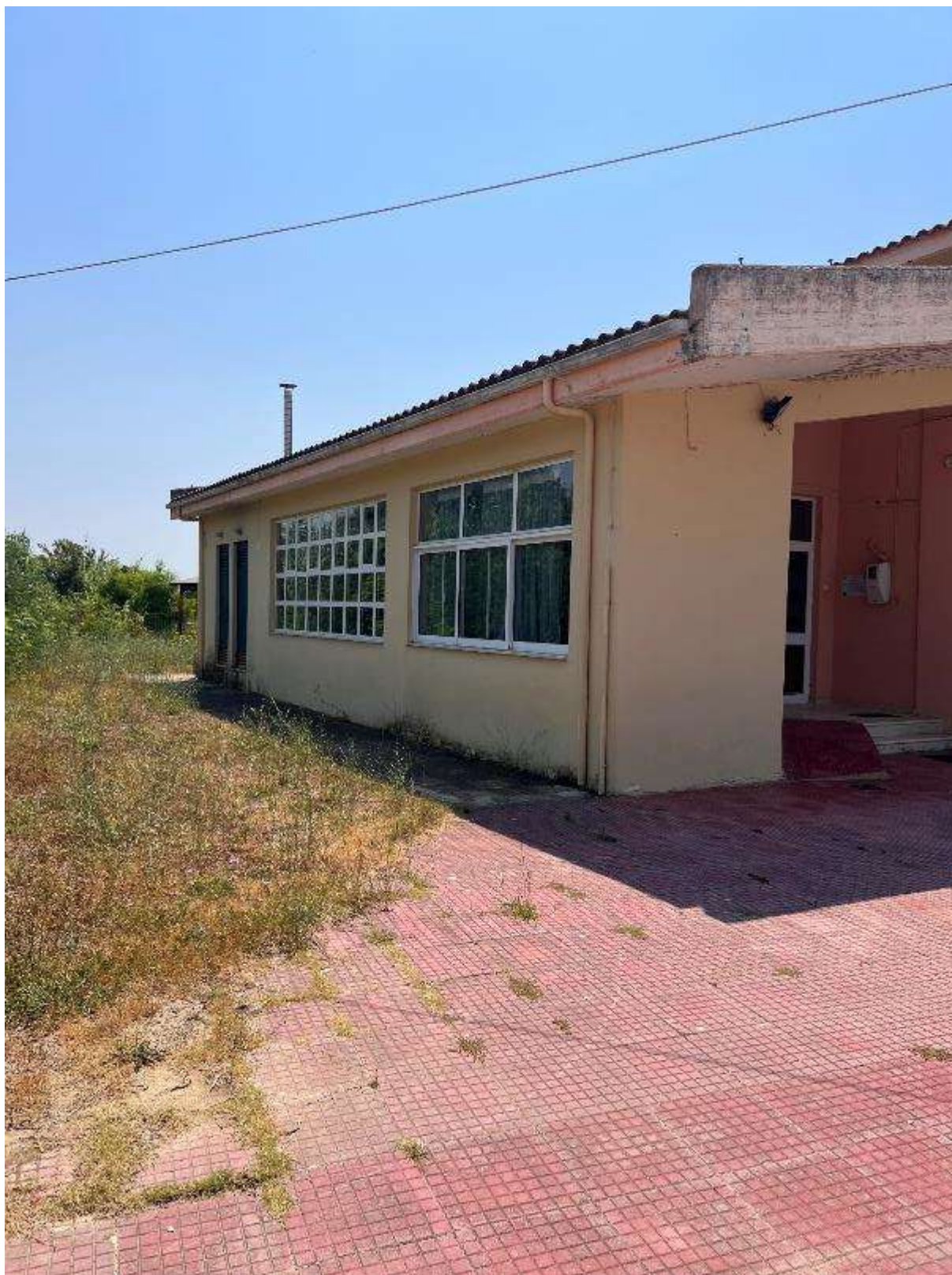
Εικόνα 271: Πλάγια όψη (Νηπιαγωγείο Ανέζας – Κωδικός θέσης: Δ.Κ._43)
