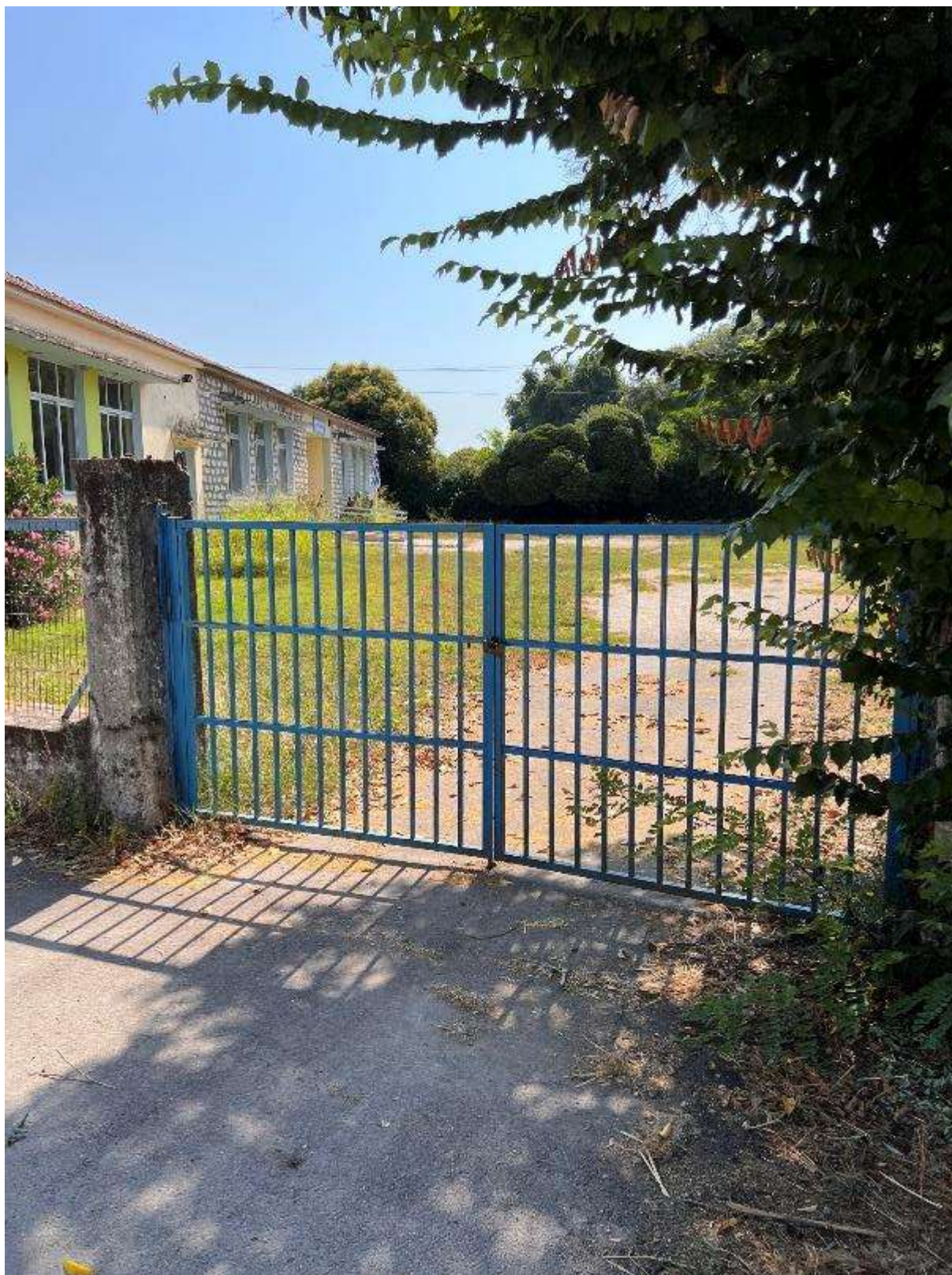
Εικόνα 288: Κεντρική είσοδος (Νηπιαγωγείο & Δημοτικό Σχολείο Πολύδροσου – Κωδικός θέσης: Δ.Κ._49)
