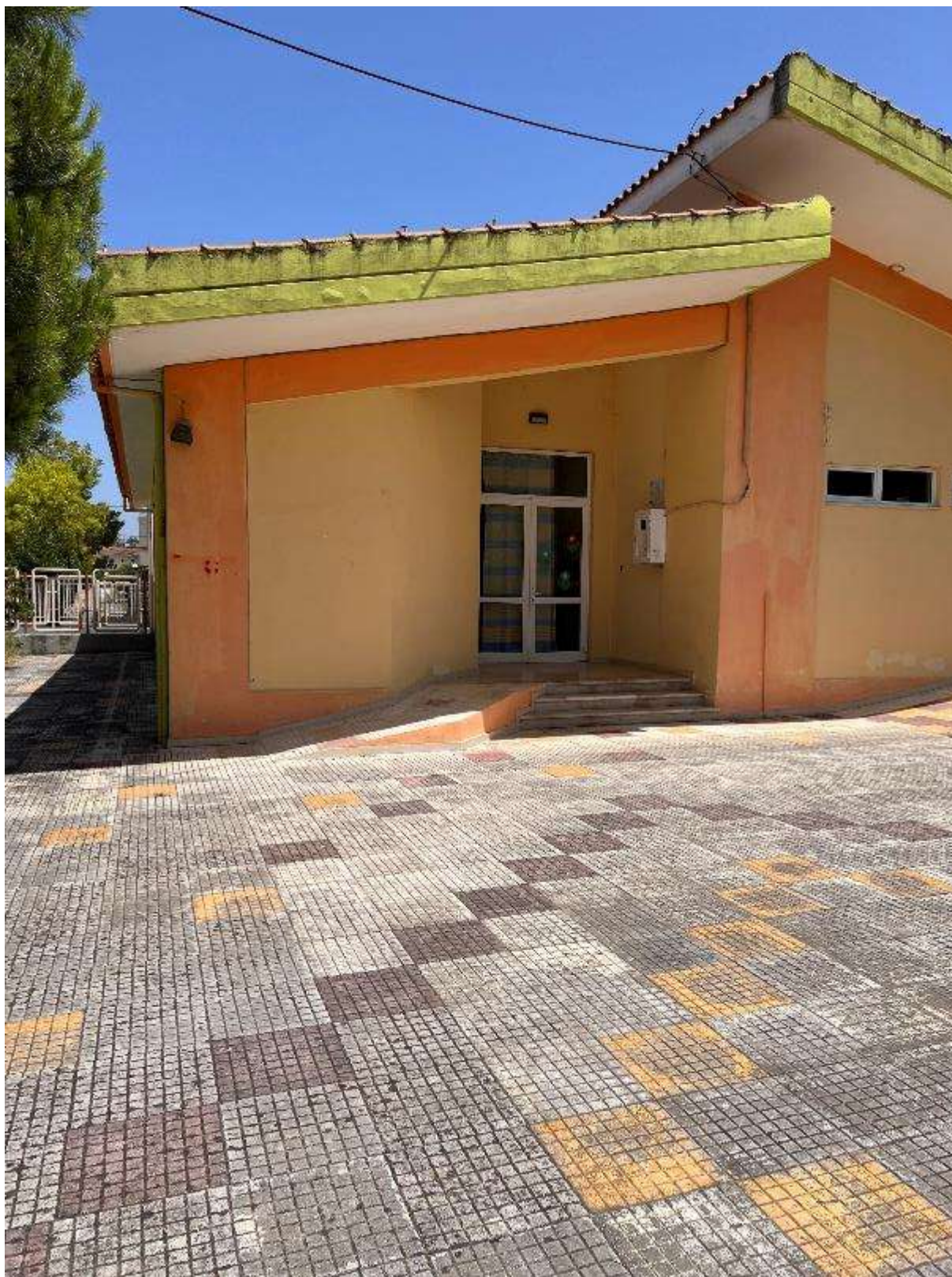
Εικόνα 242: Πλάγια όψη (Νηπιαγωγείο Ελεούσας – Κωδικός θέσης: Δ.Κ._31)
