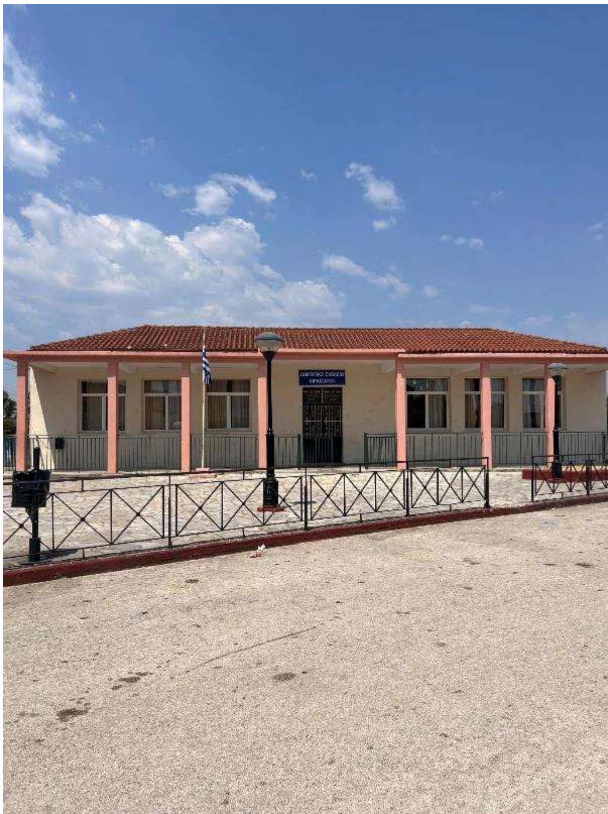
Εικόνα 305: Πλάγια όψη 1 (Δημοτικό Σχολείο Κιρκιζάτων – Κωδικός θέσης: Δ.Κ._55)
