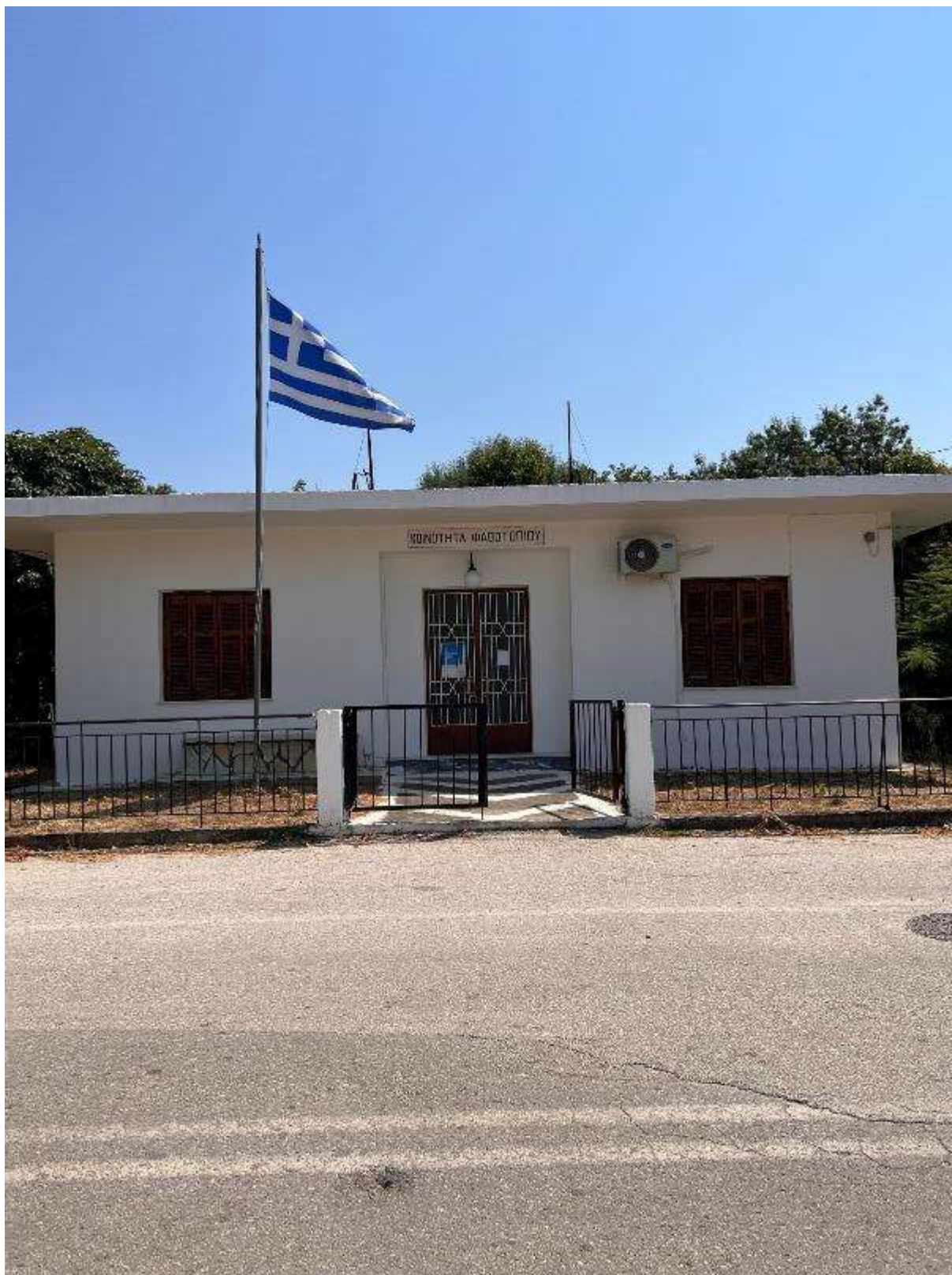
Εικόνα 295: Κεντρική είσοδος (Κοινοτικό Κατάστημα Ψαθοτοπίου – Κωδικός θέσης: Κ.Χ. 52)
