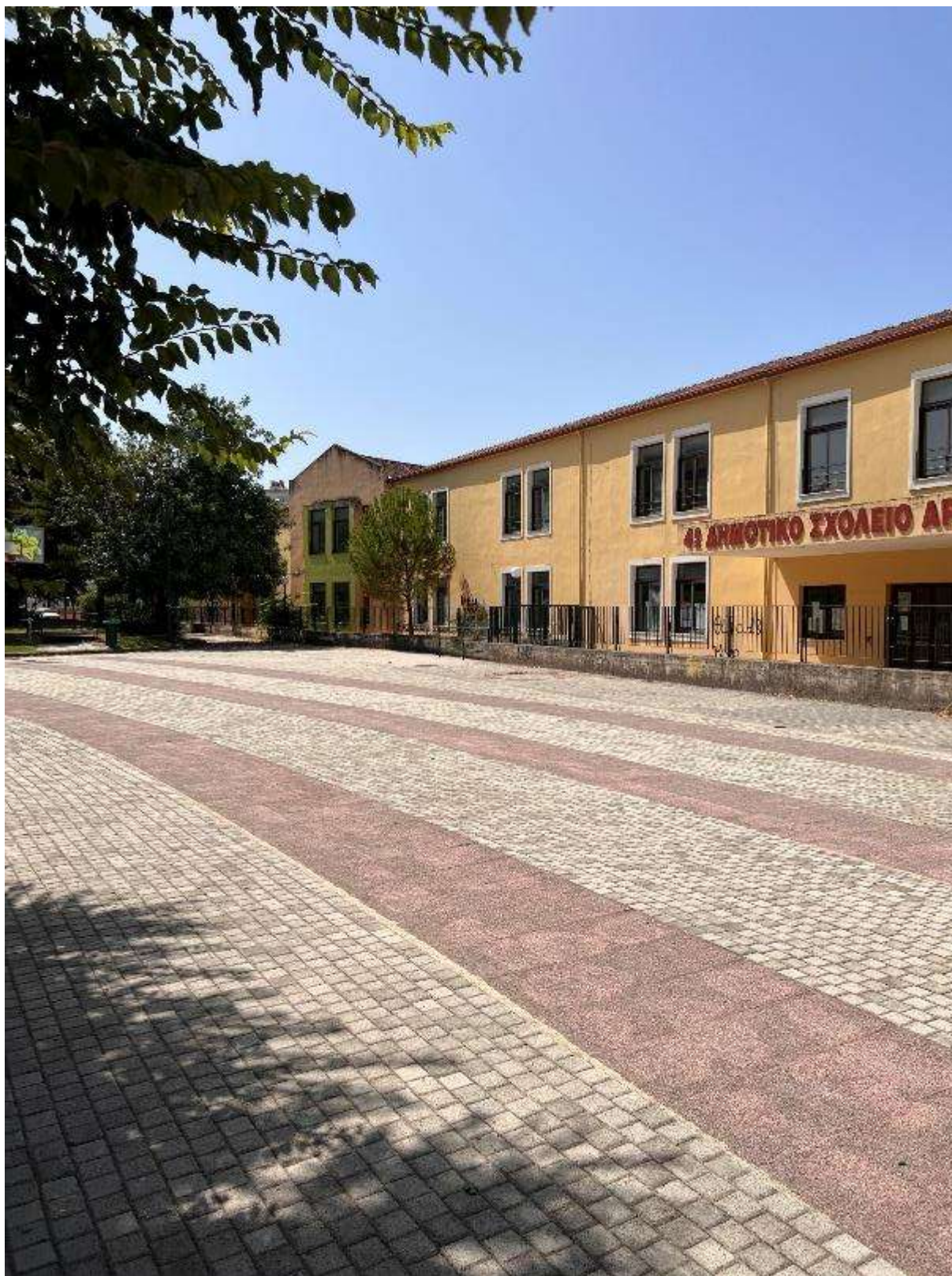
Εικόνα 175: Πλάγια όψη Δημοτικού (4 ο Νηπιαγωγείο & 4 ο Δημοτικό Σχολείο Αρτας – Κωδικός θέσης: Δ.Κ._11)
