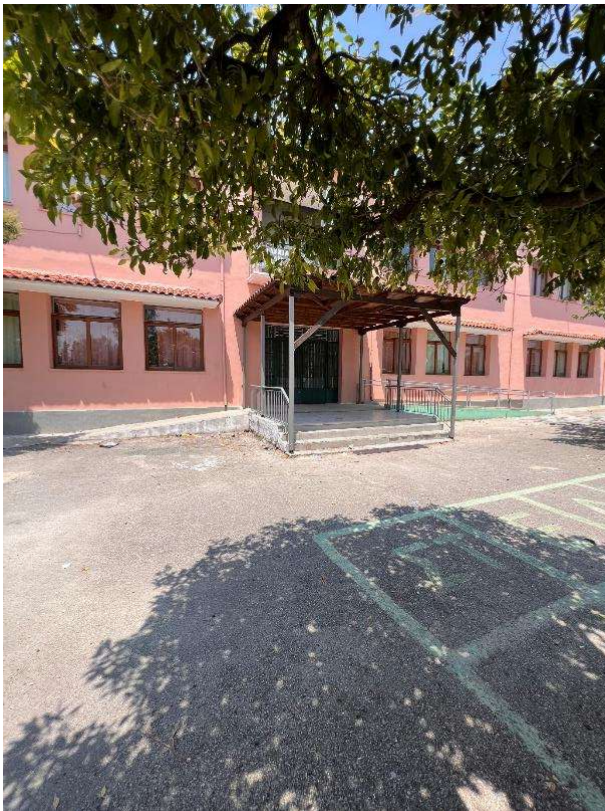
Εικόνα 297: Κεντρική είσοδος Πλάγια όψη (Νηπιαγωγείο & Δημοτικό Σχολείο Αγίου Σπυρίδωνα – Κωδικός θέσης: Δ.Κ._53)
