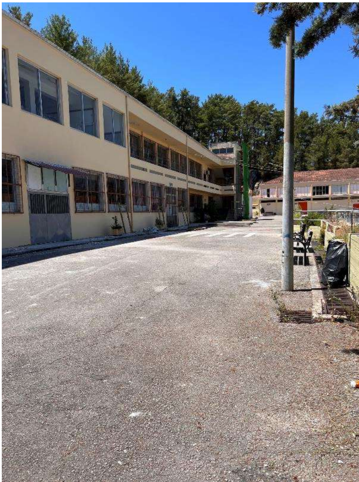
Εικόνα 238: Όψη 1 (1 ο ΕΠΑ.Λ. & 1 ο Ε.Κ. & Εσπερινό ΕΠΑ.Λ. & ΕΝ.Ε.Ε.ΓΥ.Λ. Άρτας – Κωδικός θέσης: Δ.Κ._30)
