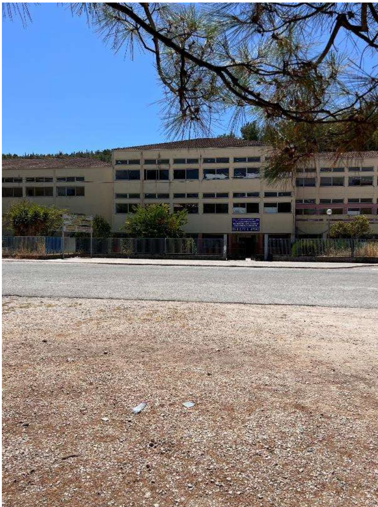
Εικόνα 234: Όψη 1 (Εσπερινό Γυμνάσιο & Εσπερινό ΓΕ.Λ Αρτας – Κωδικός θέσης: Δ.Κ._29)
