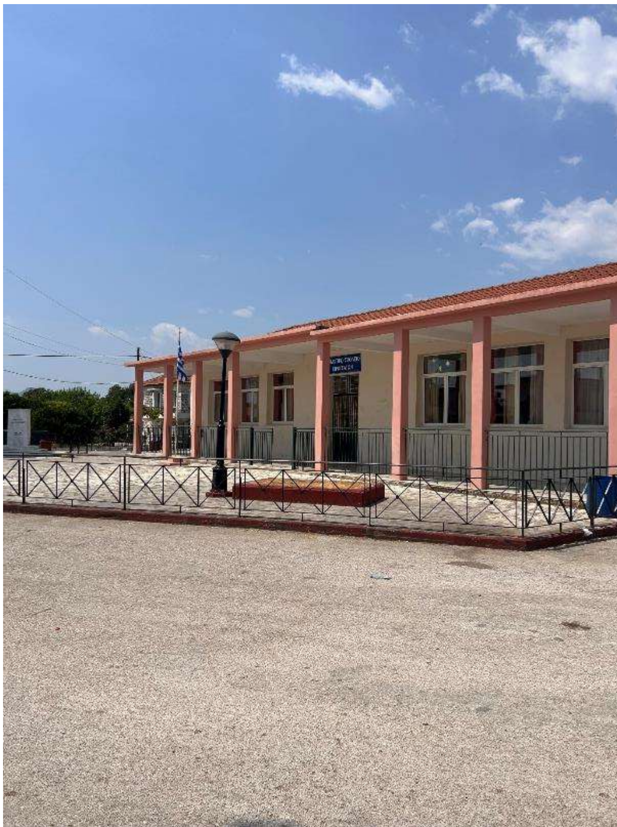
Εικόνα 306: Πλάγια όψη 2 (Δημοτικό Σχολείο Κιρκιζάτων – Κωδικός θέσης: Δ.Κ._55)
