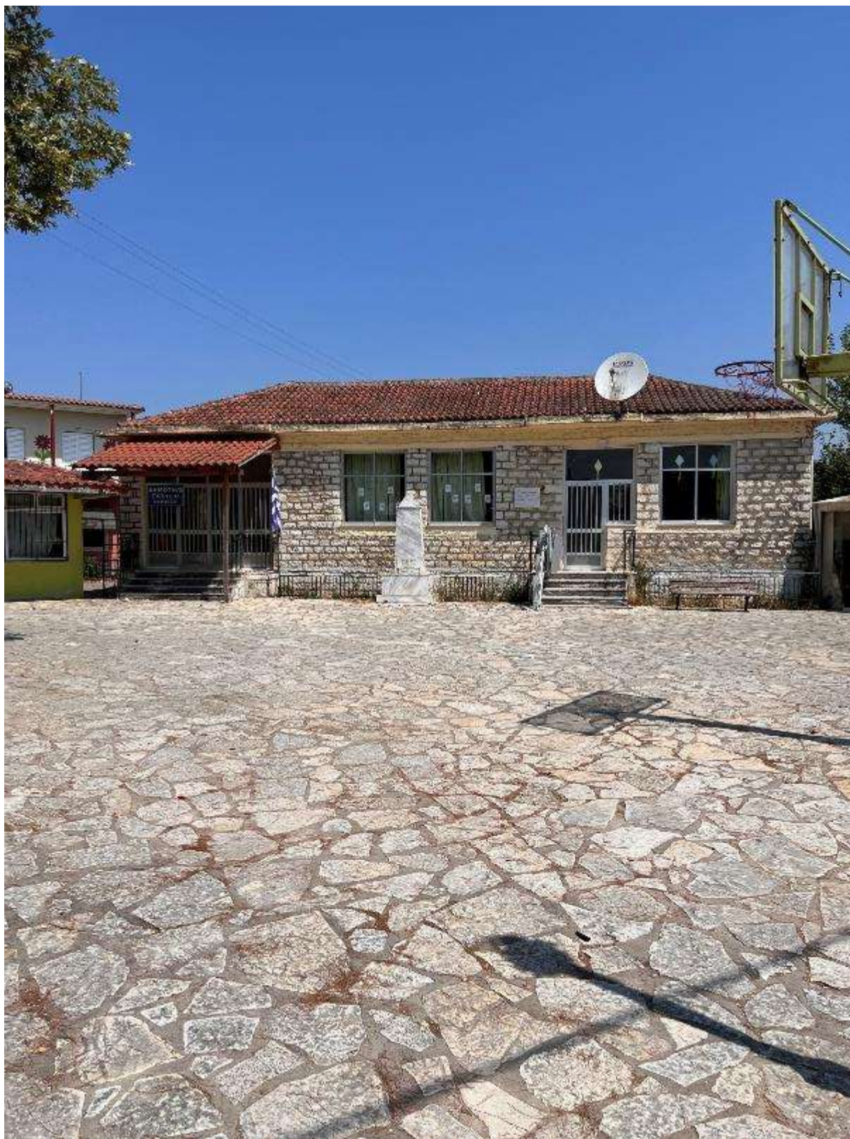
Εικόνα 284: Κεντρική είσοδος (Δημοτικό Σχολείο Γαβριάς – Κωδικός θέσης: Κ.Χ._47)
