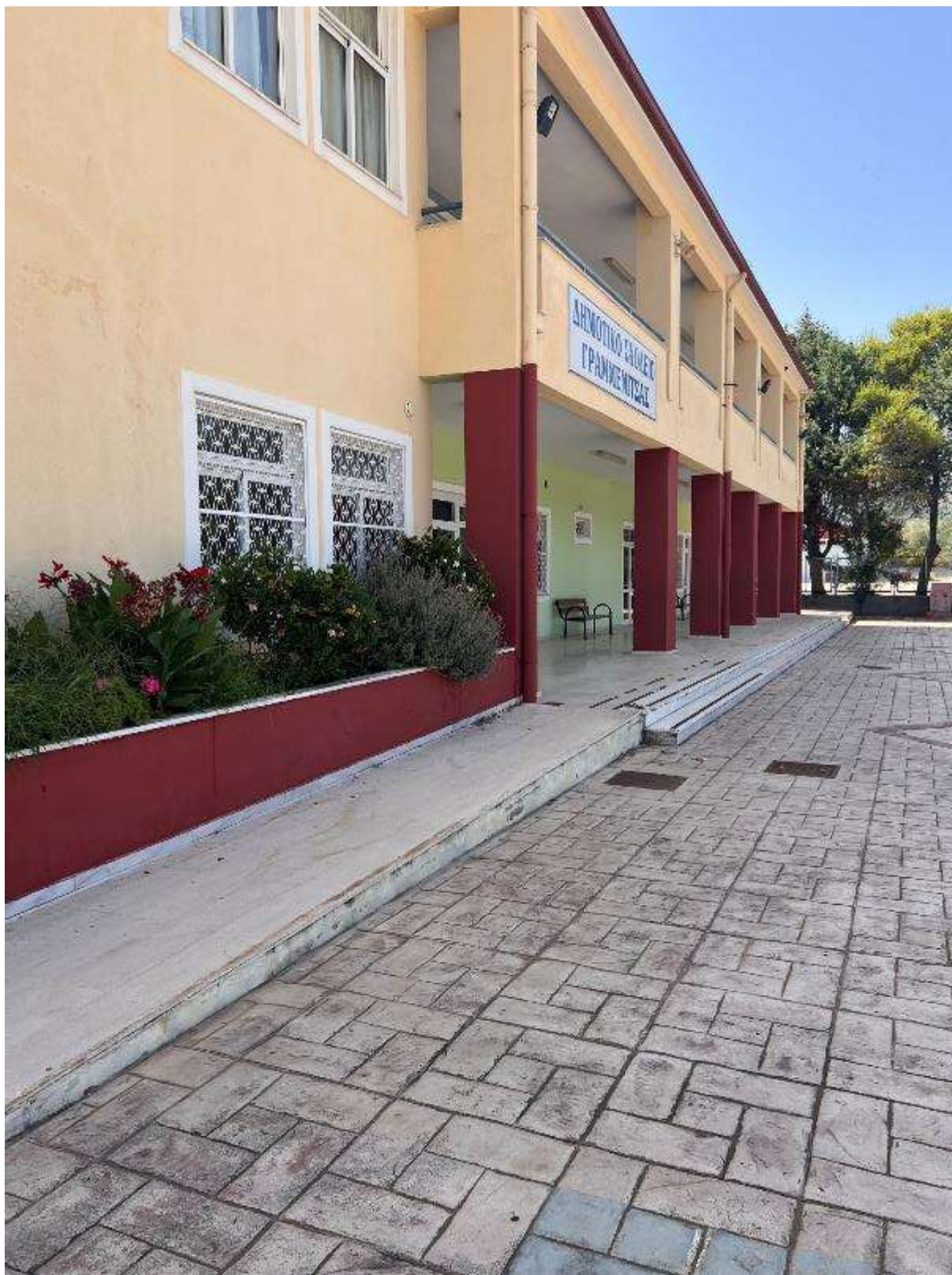
Εικόνα 258: Πλάγια όψη (Δημοτικό Σχολείο Γραμμενίσσας – Κωδικός θέσης: Δ.Κ._37)
