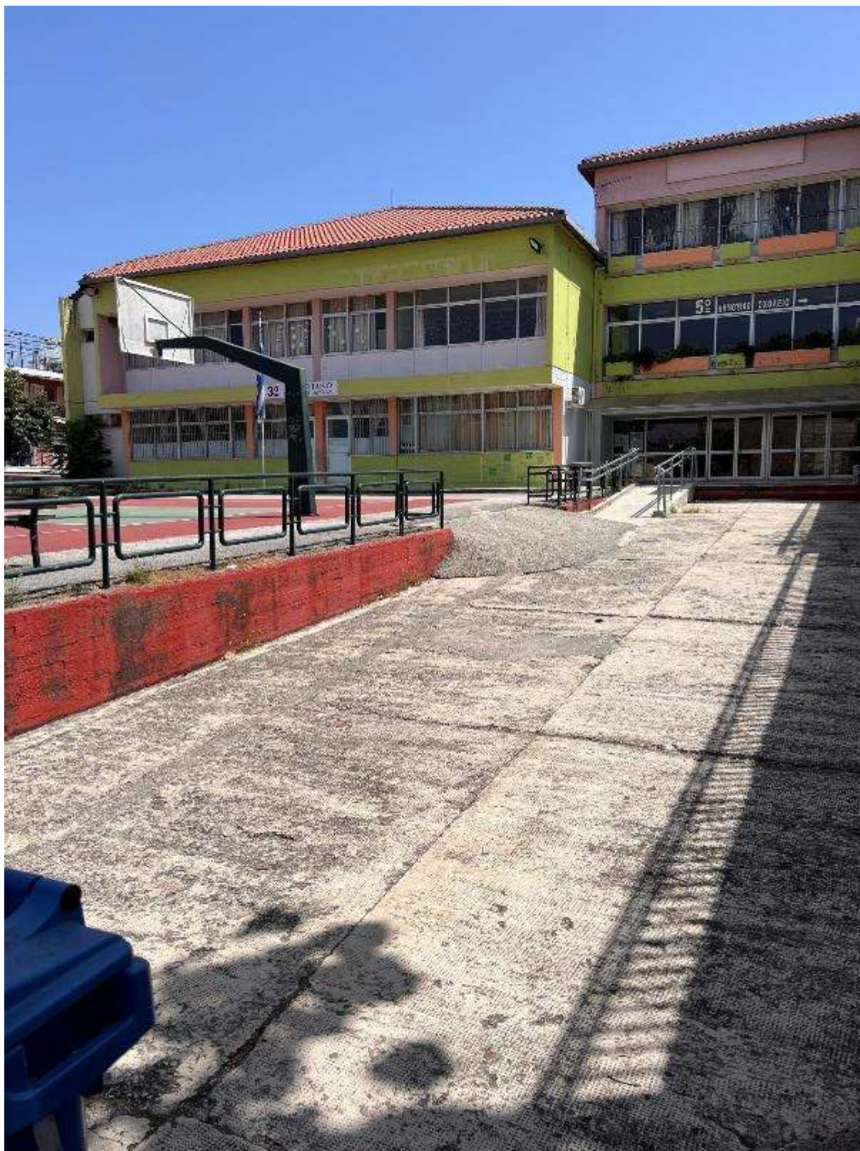
Εικόνα 205: Όψη κτιρίου (3 ο Δημοτικό Σχολείο & 5 ο Δημοτικό Σχολείο Αρτας – Κωδικός θέσης: Δ.Κ._21)
