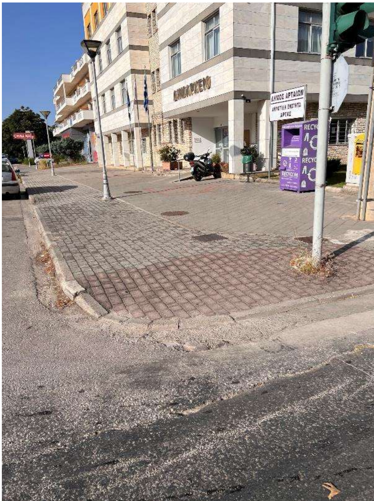
Εικόνα 146: Πρόσοψη κτιρίου – ράμπα πεζοδρομίου (Δημαρχείο Άρτας – Κωδικός θέσης: Δ.Κ._1)
