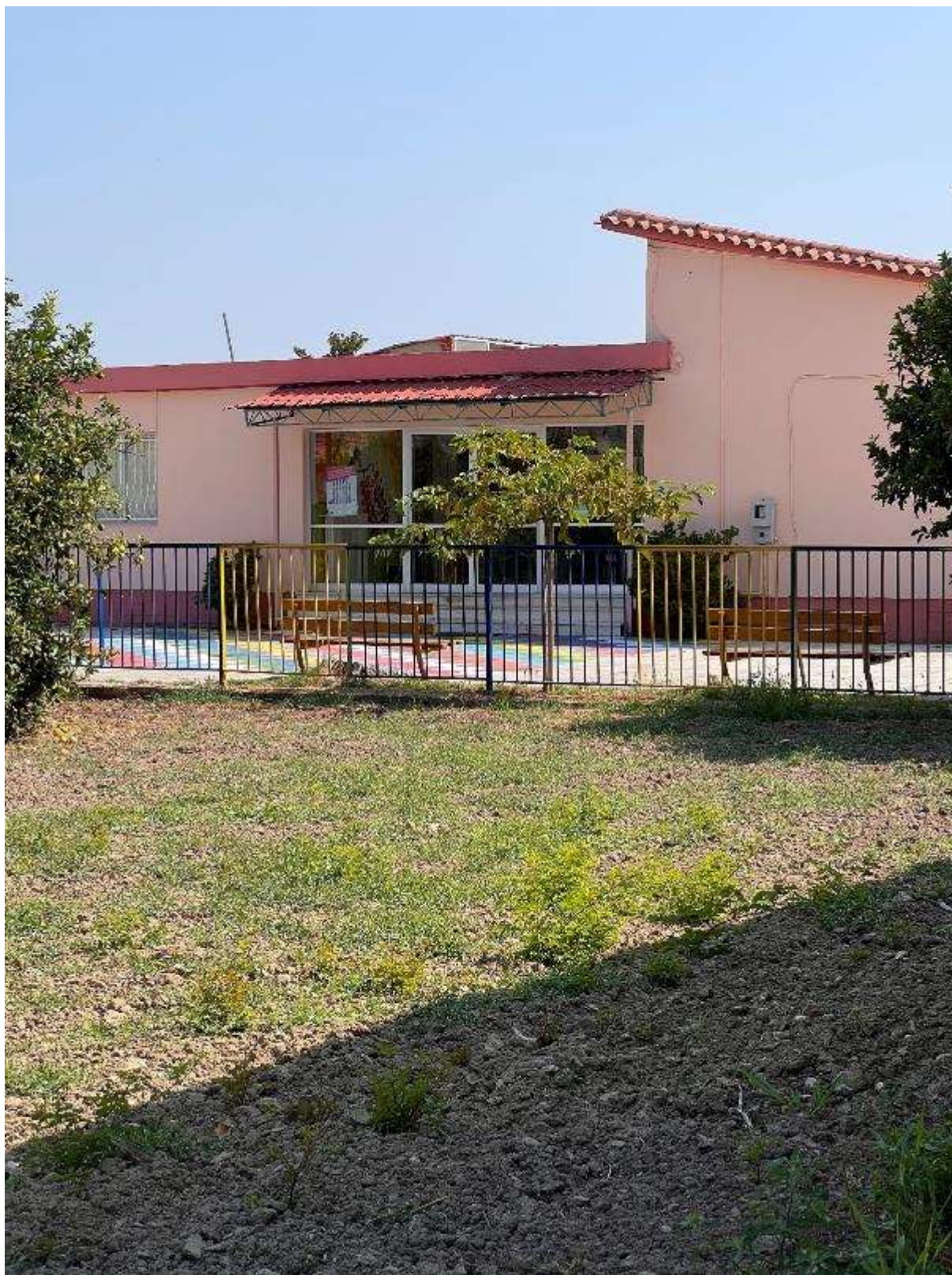
Εικόνα 294: Όψη 2 (Νηπιαγωγείο & Δημοτικό Σχολείο Ράχης – Κωδικός θέσης: Δ.Κ._51)
