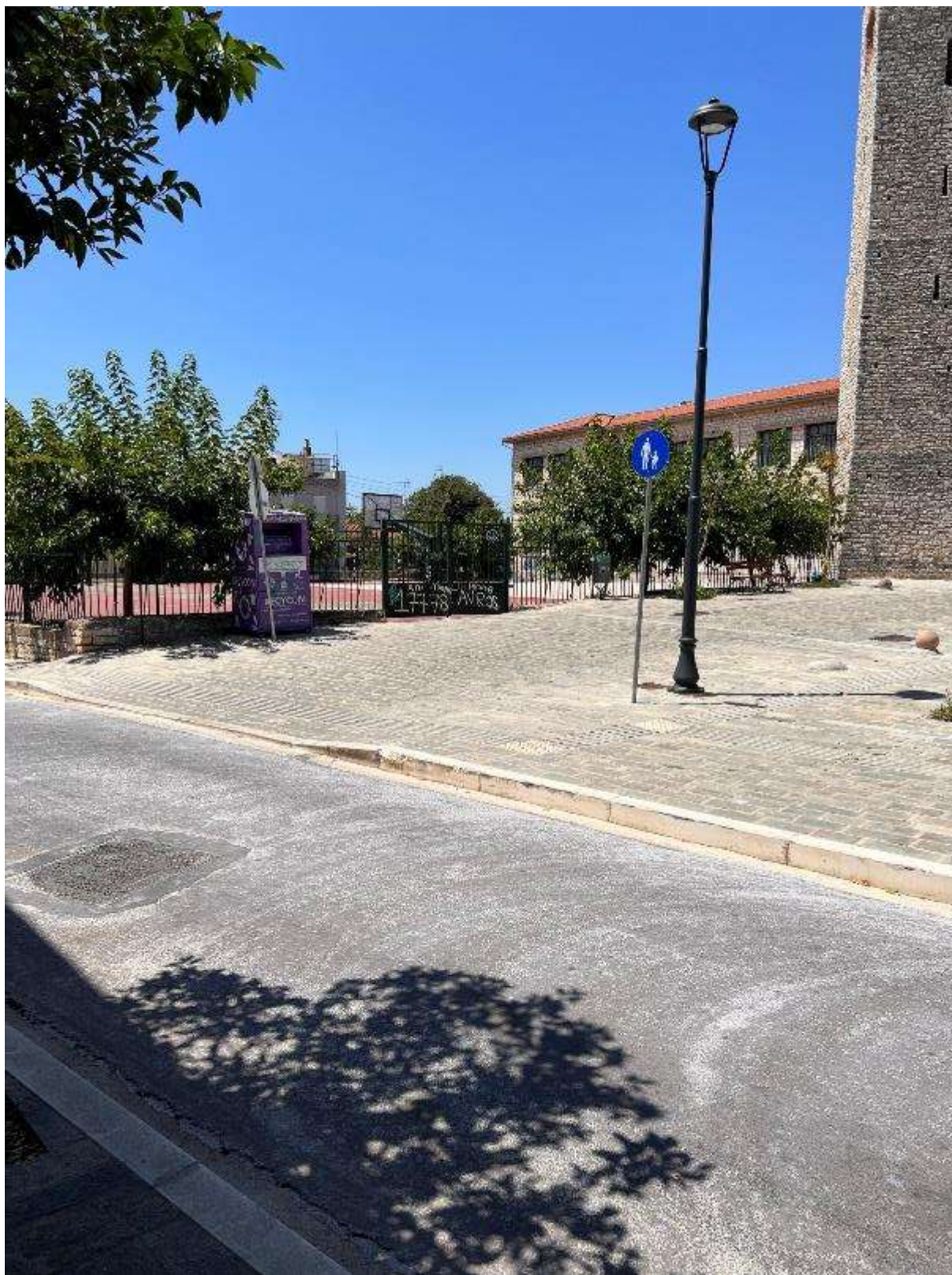
Εικόνα 200: Πλάγια όψη κεντρικής εισόδου (2 ο Δημοτικό Σχολείο Άρτας – Κωδικός θέσης: Δ.Κ._20)
