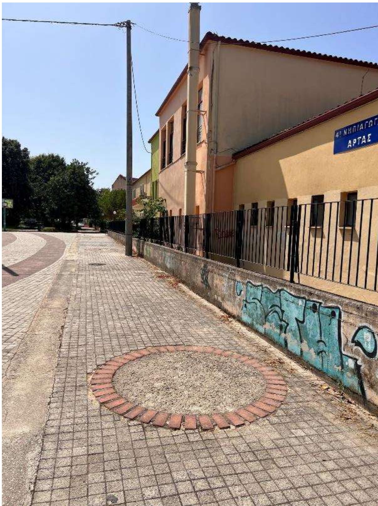
Εικόνα 174: Πλάγια όψη Νηπιαγωγείου (4 ο Νηπιαγωγείο & 4 ο Δημοτικό Σχολείο Αρτας – Κωδικός θέσης: Δ.Κ._11)
