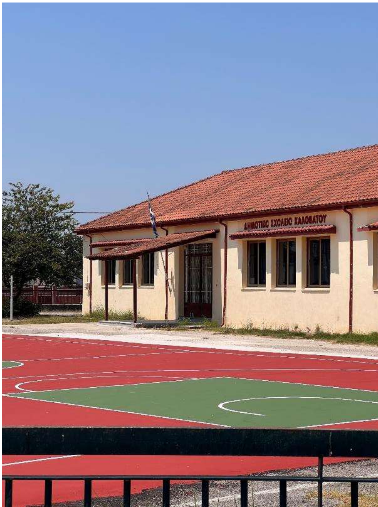
Εικόνα 304: Όψη 4 (Νηπιαγωγείο & Δημοτικό Σχολείο Καλόβατου – Κωδικός θέσης: Δ.Κ._54)
