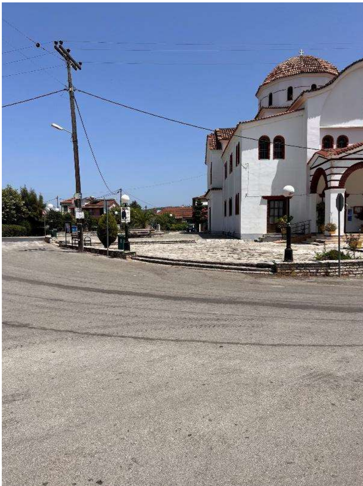
Εικόνα 48: Βορειοδυτική όψη πλατείας (Πλατεία Κωστακίων – Κωδικός θέσης: Κ.Χ._9)
