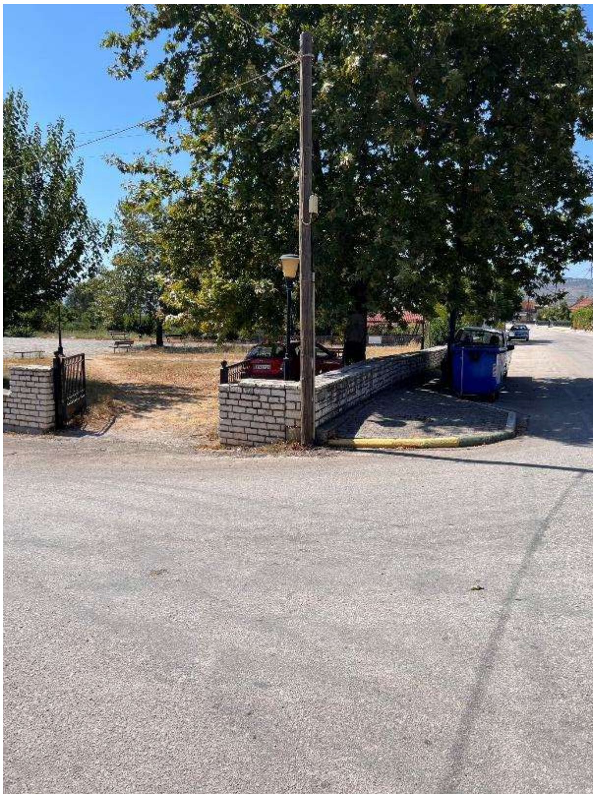
Εικόνα 65: Νότια όψη – είσοδος στην πλατεία (Πλατεία Χανόπουλου – Κωδικός θέσης: Κ.Χ._14)
