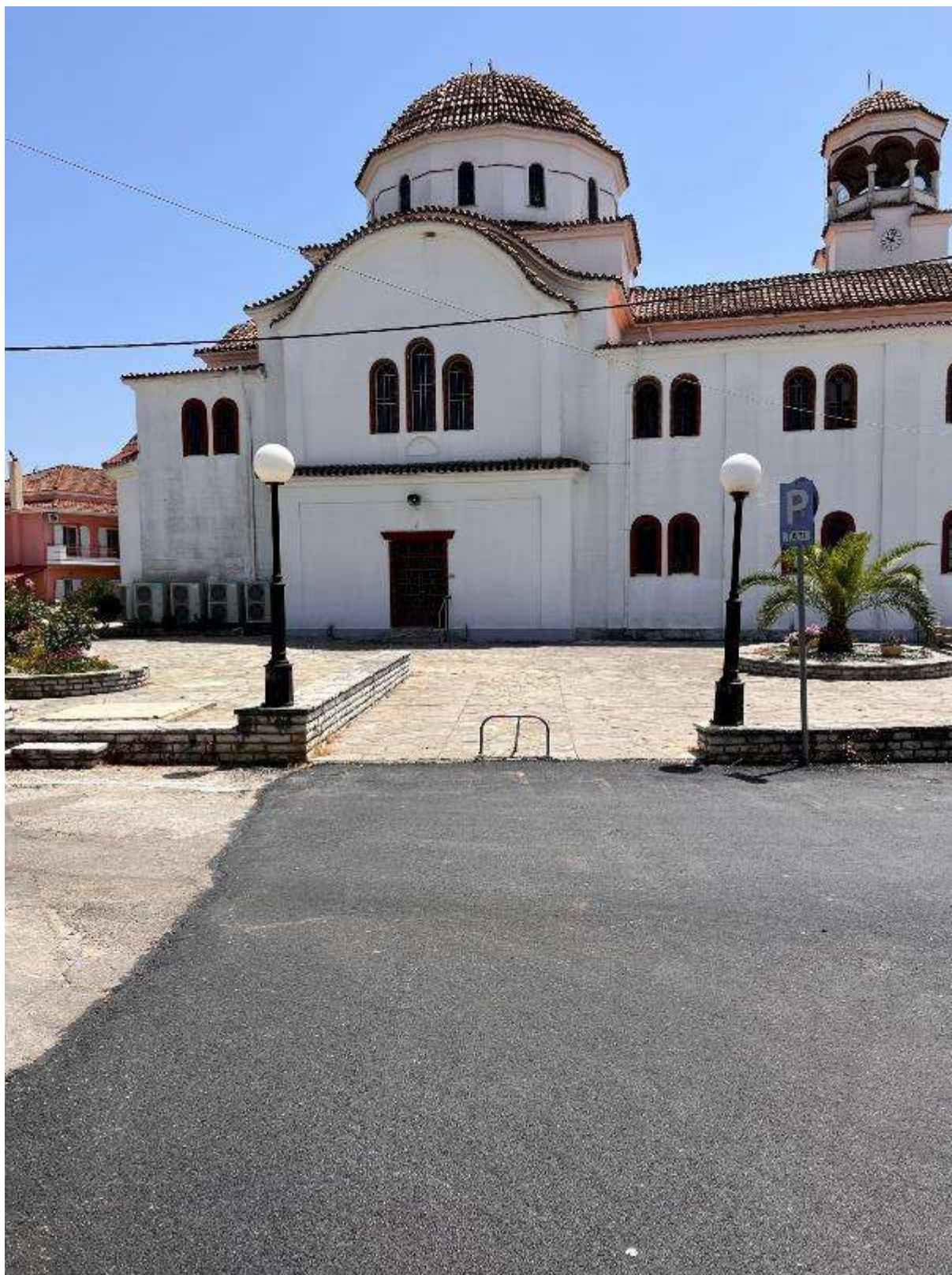
Εικόνα 49: Βόρεια όψη πλατείας – κατάληξη οδού Αγίου Γεωργίου (Πλατεία Κωστακιών – Κωδικός θέσης: Κ.Χ._9)
