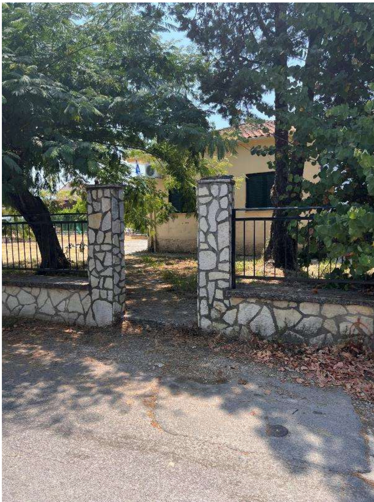
Εικόνα 114: Ανατολική πλευρά – είσοδος (Πλατεία Καλαμιάς – Κωδικός θέσης: Κ.Χ._27)
