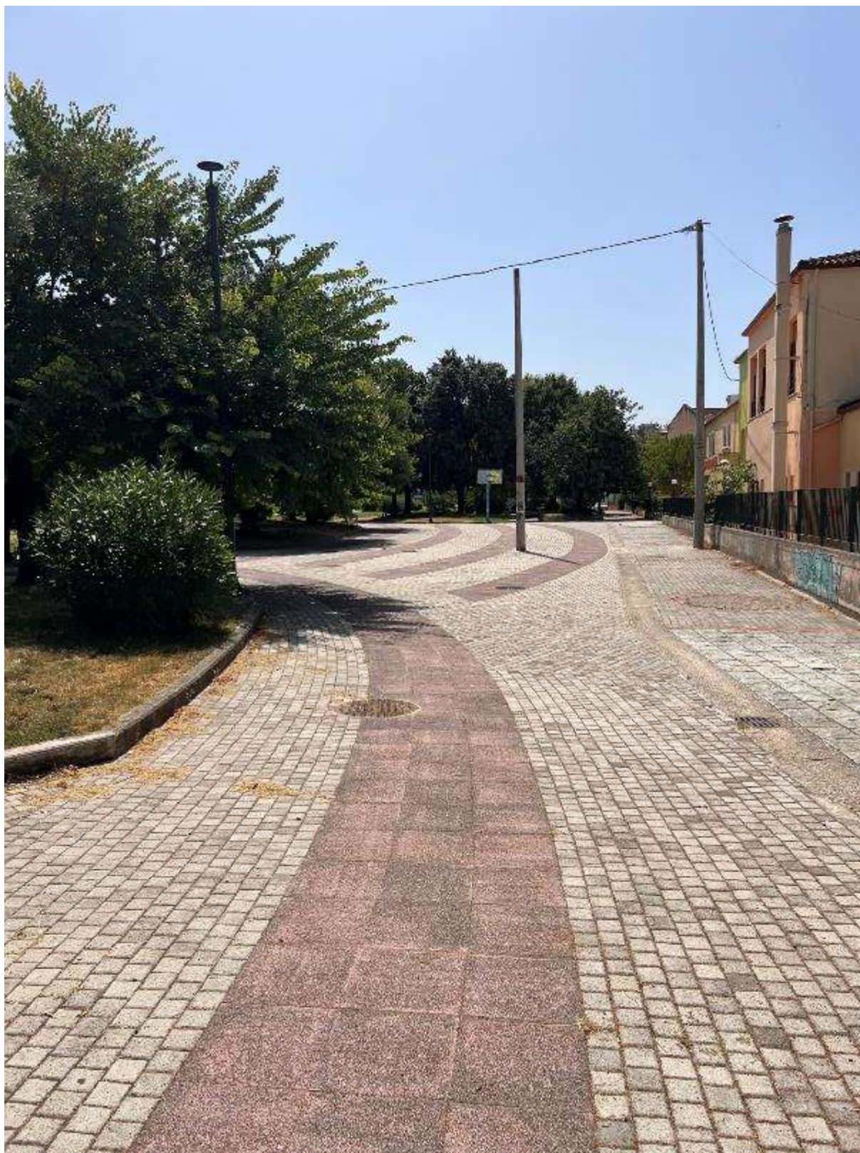
Εικόνα 24: Πεζόδρομος στην δυτική πλευρά της πλατείας (Πλατεία Καραϊσκάκη – Κωδικός θέσης: Κ.Χ._3)
