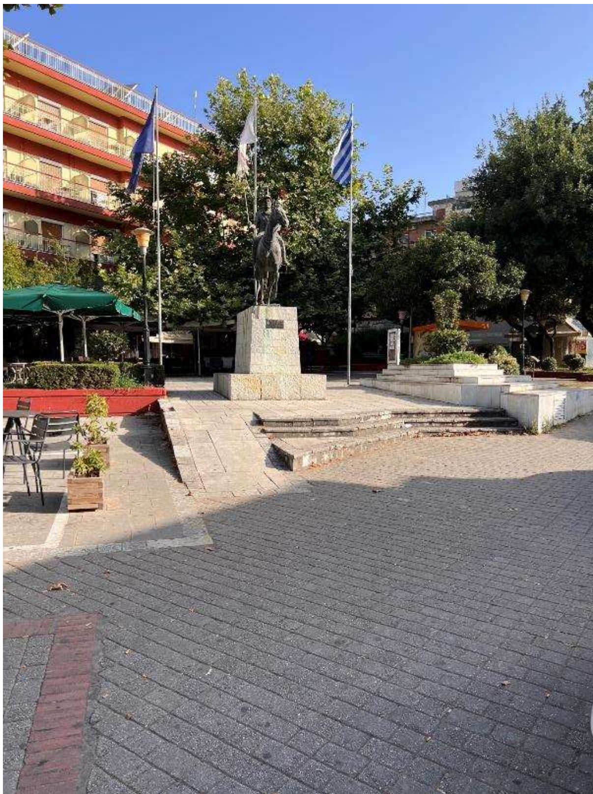
Εικόνα 40: Ανισοσταθμία επιπέδων της πλατείας (Πλατεία Κιλκίς – Κωδικός θέσης: Κ.Χ._6)
