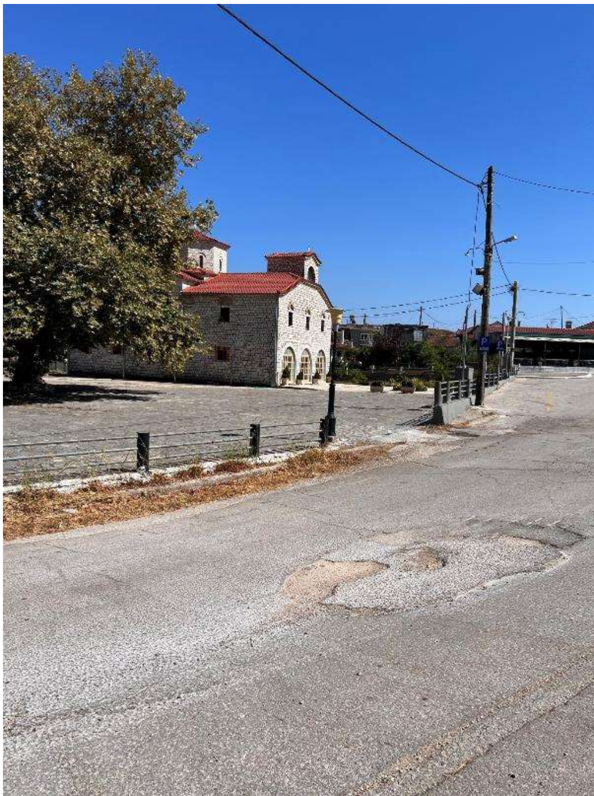
Εικόνα 131: Βόρεια πλευρά πλατείας – διαμορφωμένη ράμπα εισόδου (Πλατεία Καμπής – Κωδικός θέσης: Κ.Χ._32)
