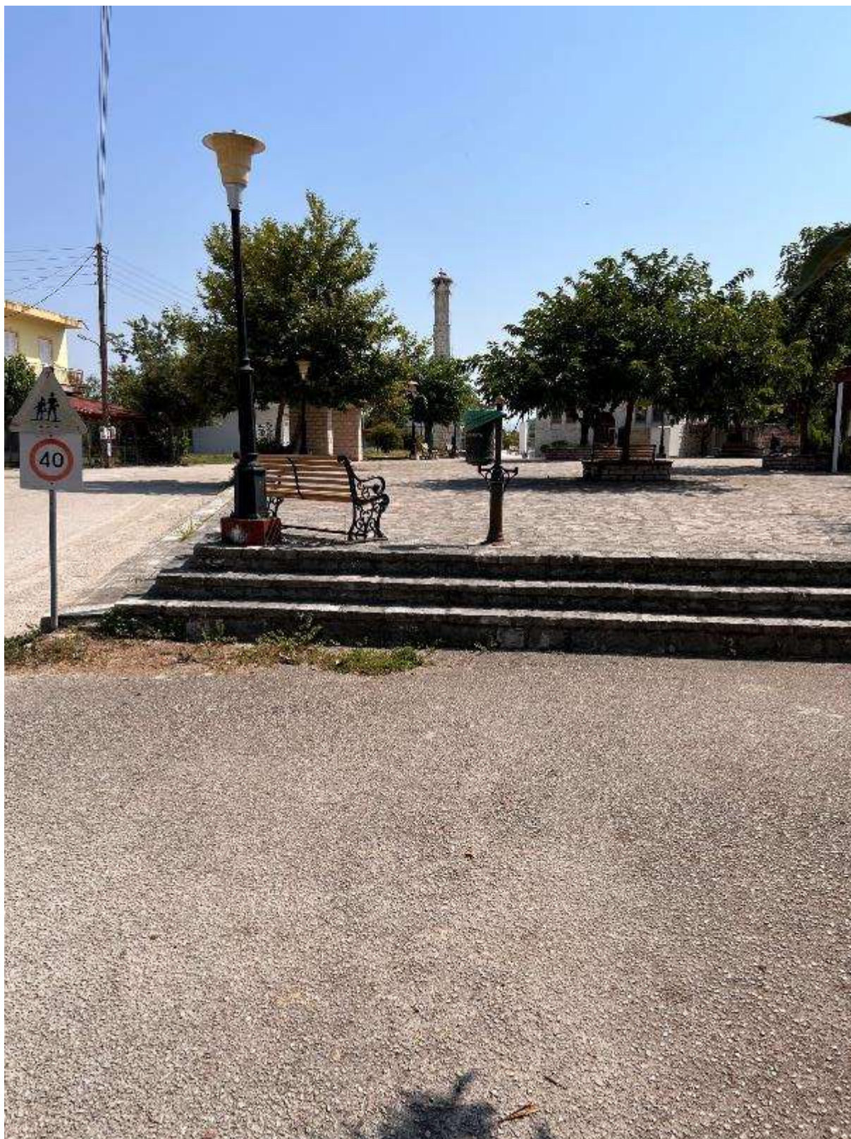
Εικόνα 99: Δυτική γωνία – διαφορά επιπέδων (Πλατεία Ράχης – Κωδικός θέσης: Κ.Χ._23)
