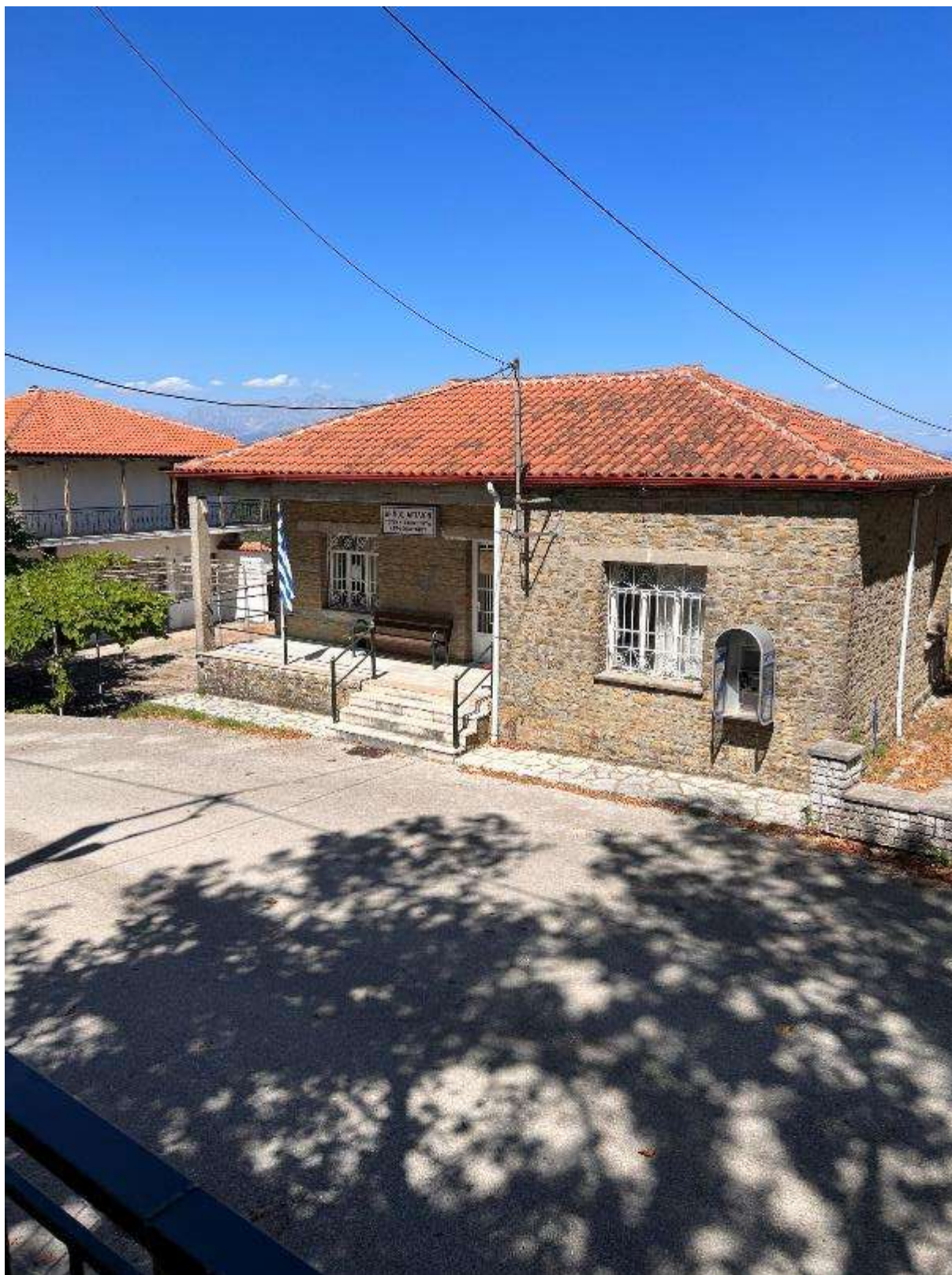
Εικόνα 68: Βόρεια γωνία πλατείας – Κοινοτικό κατάστημα (Πλατεία Κορφοβουνίου– Κωδικός θέσης: Κ.Χ._15)
