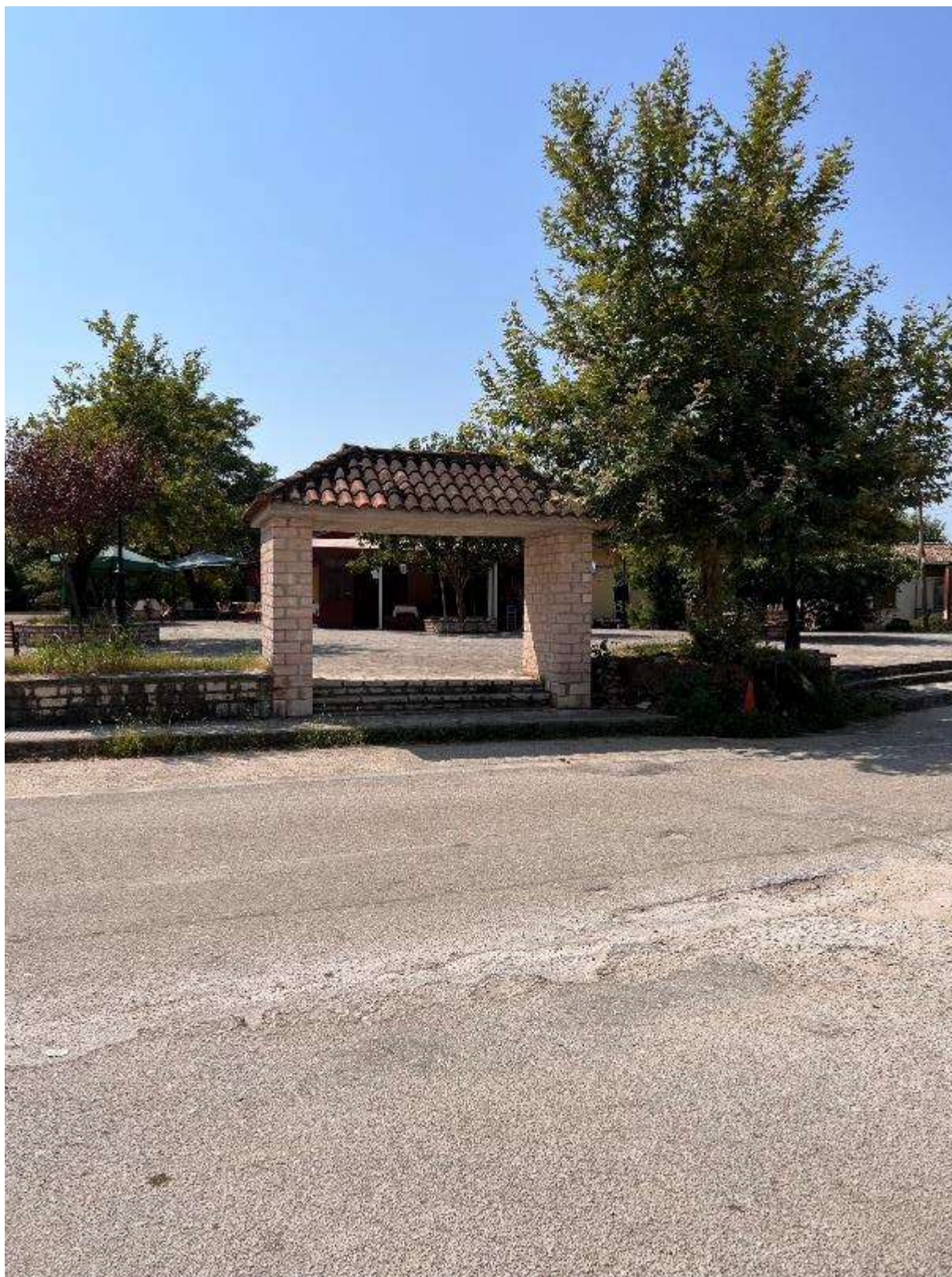
Εικόνα 97: Βόρεια πλευρά – κύρια είσοδος (Πλατεία Ράχης – Κωδικός θέσης: Κ.Χ._23)
