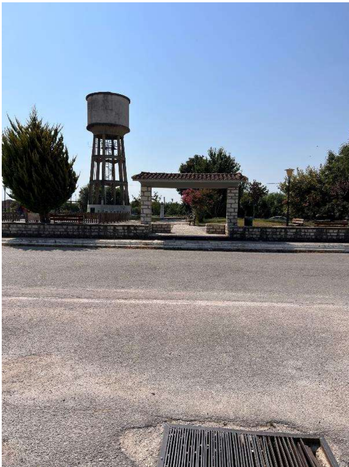
Εικόνα 94: Βορειοανατολική πλευρά πλατείας – κύρια είσοδος (Πλατεία Πολύδροσου – Κωδικός θέσης: Κ.Χ._22)
