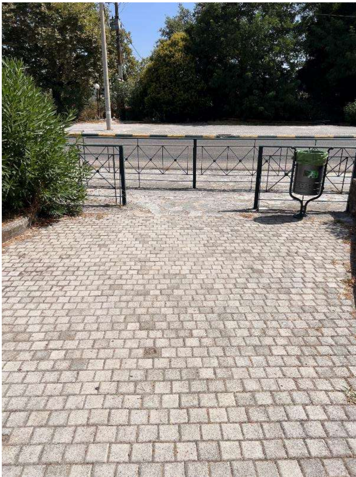
Εικόνα 26: Μηδενική υψομετρική διαφορά πλατείας – πεζοδρομίου επί της Εθνικής Οδού Αντιρρίου – Ιωαννίνων (Πλατεία Καραϊσκάκη – Κωδικός θέσης: Κ.Χ._3)
