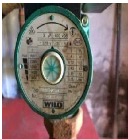
Εικόνα 4.2 Ο κυκλοφορητής στο σύστημα θέρμανσης και η πινακίδα του καυστήρα
