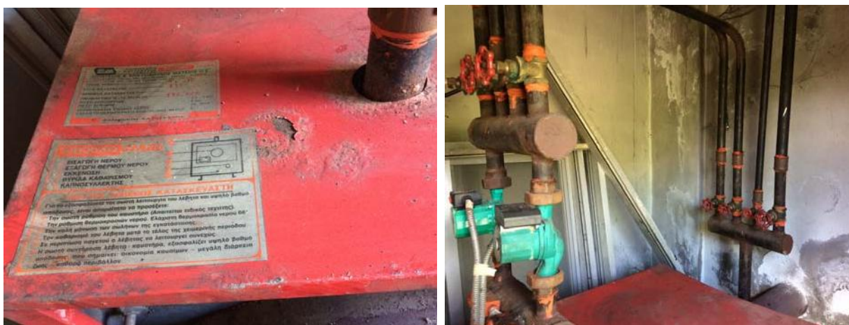
Εικόνα 4.1 Πινακίδα λέβητα και δίκτυο διανομής και κυκλοφορητές
