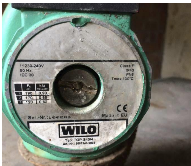
Εικόνα 4.3 Ο κυκλοφορητής στο σύστημα θέρμανσης του παλαιού κτιρίου
