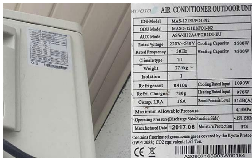
Εικόνα 4.5 Στοιχεία τοπικής κλιματιστικής μονάδας απ' ευθείας εκτόνωσης (split unit)
