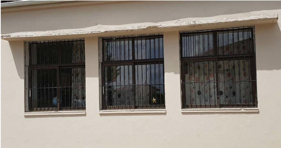
Εικόνα 3.9 Τυπικά κουφώματα του θερμαινόμενου χώρου στο παλαιό κτίριο
