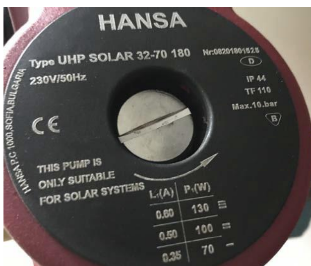
Εικόνα 4.4 Ο κυκλοφορητής στο σύστημα θέρμανσης του νέου κτιρίου
