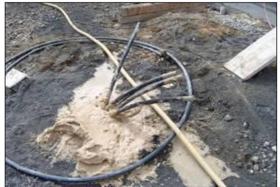
Εικόνα 3.4: Άποψη πληρωμένου με κονίαμα κατακόρυφου ΓΕΘ διπλού σωλήνα σχήματος "U"
