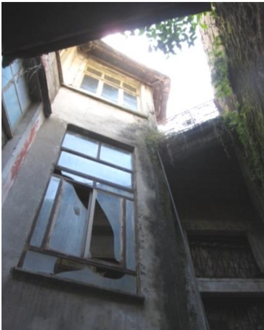
Εικ. 4.2.19. Ακάλυπτος 2. Καθαίρεση υποστυλώματος από ωπλισμένο σκυρόδεμα, νέωτης οπτοπλινθοδομής και μεταλλικού παραθύρου. Κατασκευή ξυλόπηκτου τοίχου και ξύλινων κουφωμάτων σε αντιγραφή των παλαιότερων.
