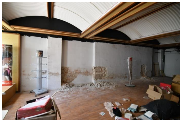
Εικ. 4.2.6. Ι-4. Καθαίρεση νεώτερης ψευδοροφής και λοιπών ασύμβατων προσθηκών.
