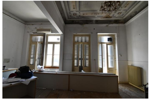
Εικ. 4.4.2. Άποψη των χώρων A-7 και A-8, ανάμεσα στους οποίους θα κτιστεί διαχωριστικός μπαγδατότοιχος στην αρχική του θέση με τετράφυλλο άνοιγμα.
