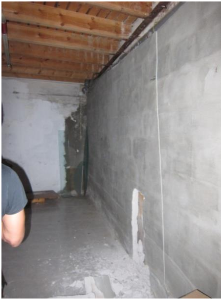
Εικ. 4.3.3. Ο τοίχος από τσιμεντόπλιθους για την αντιμετώπιση της υγρασίας στον χώρο Υ-7. Προτείνεται η καθαίρεσή του, με ταυτόχρονες εργασίες αποστράγγισης στον όμορο επιχωμένο χώρο κάτω από τον κεντρικό διάδρομο Ι-1.
