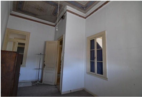
Εικ. 4.4.1. Άποψη των χώρων A-4 και A-5. Οι δύο τοίχοι στο κέντρο απομακρύνονται και στη θέση τους τοποθετείται ανελκυστήρας, χωρίς να επηρεαστούν οι γύψινες διακοσμήσεις και οι οροφोगραφίες. Τα δύο παράθυρα εκατέρωθεν μετατρέπονται σε θύρες ιδίου ανοίγματος.
