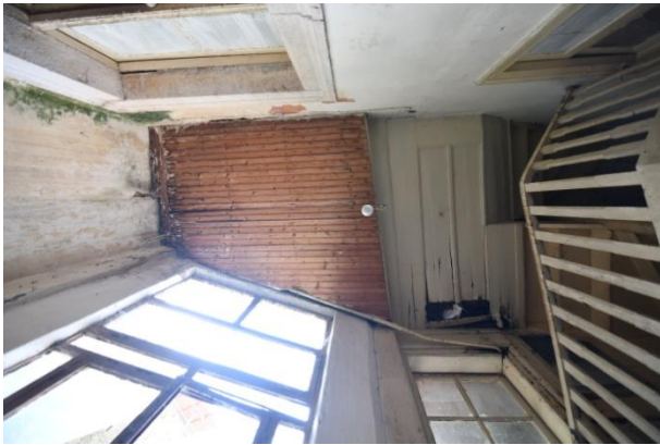
Εικ. 4.2.21. Ενότητα Γ, χώρος Ι-10. Καθαίρεση προσθηκών και αποκατάσταση ξύλινης οροφής στην αρχική της μορφή.
