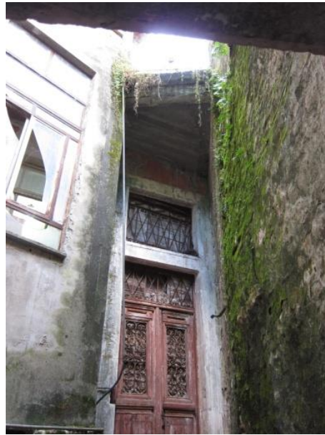
Εικ. 4.4.10. Άποψη του προβόλου από οπλισμένο σκυρόδεμα στη συνέχεια της βεράντας, πάνω από τη φραγμένη θύρα προς τον ακάλυπτο 2. προτείνεται η καθαίρεσή του και η κατασκευή μεταλλικού στεγάστρου.
