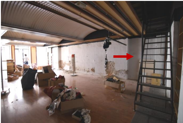
Εικ. 4.2.7. Η θέση της προτεινόμενης διάνοιξης για τη σύνδεση του χώρου πολλαπλών χρήσεων με τον κεντρικό διάδρομο.
