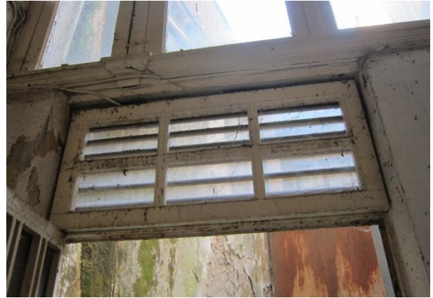
4.6.4. Το άνοιγμα Θ.Ι.10. Διασώζεται επίκρानο ορθοστάτη.
