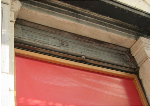
4.6.3. Διακρίνεται το παλαιότερο ρολό εγκιβωτισμένο στις νεώτερες επεμβάσεις.
