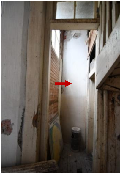
Εικ. 4.2.23. Ενότητα Γ. Απαιτείται διερεύνηση του φραγμένου με οπτοπλινθοδομή χώρου βόρεια των αιθουσών Ι-11 και Ι-12
