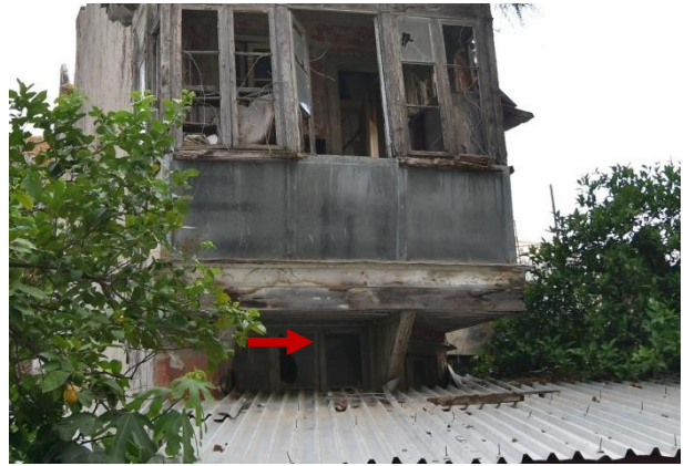
Εικ. 4.2.22. Ενότητα Γ. Απαιτείται διερεύνηση του φραγμένου με οπτοπλινθοδομή χώρου βόρεια των αιθουσών Ι-11 και Ι-12
