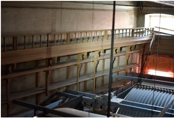
Εικ. 4.2.11. Το ανώτερο τμήμα των περιμετρικών ραφιών του παλαιού καταστήματος. Προτείνεται να αποκατασταθούν στην αρχική τους μορφή με συμπήρωση των χαμηλών τμημάτων των ορθοστατών.
