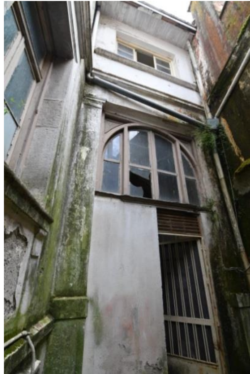
Εικ. 4.2.10. Το φραγμένο τοξωτό άνοιγμα το οποίο προτείνεται να αποκατασταθεί στην αρχική του μορφή.
