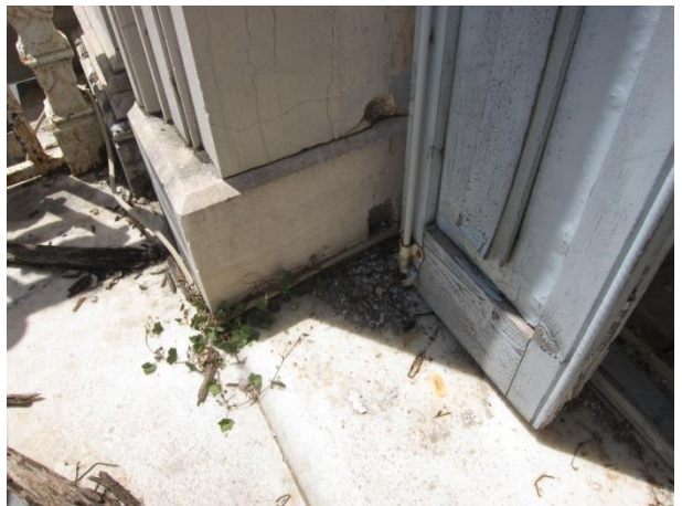
4.6.6. Οι εσοχές στον μαρμαρίνο λαμπά σε αντιστοιχία με την πατζουρόβεργα. Υπάρχουν και στο μέσο του ύψους, χωρίς όμως να συμβαίνει το ίδιο. Διακρίνεται επίσης νεώτερος ταμπλάς από MDF.
