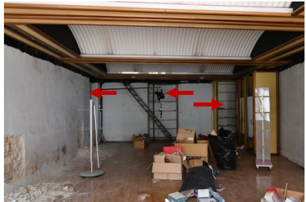
Εικ. 4.2.8. Οι θέσεις των προτεινόμενων διανοίξεων στο βόρειο άκρο του χώρου πολλαπλών χρήσεων.
