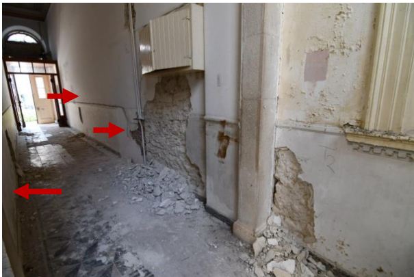
Εικ. 4.2.3. Οι θέσεις των προτεινόμενων διανοίξεων στους διαμήκεις τοίχους του κεντρικού διαδρόμου, στην θέση υπαρχουσών κογχών.
