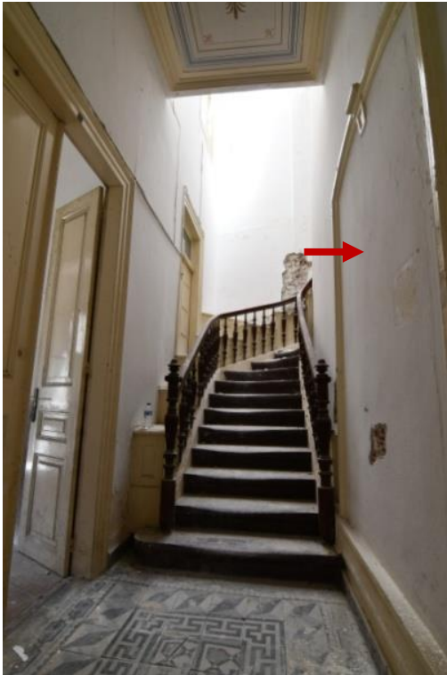
Εικ. 4.2.9. Φραγμένο άνοιγμα κλιμακοστασίου. Προτείνεται η διάνοιξή του για την σύνδεση με τον χώρο πολλαπλών χρήσεων και την πρόσβαση Α.Μ.Κ μέσω αναβατορίου.
