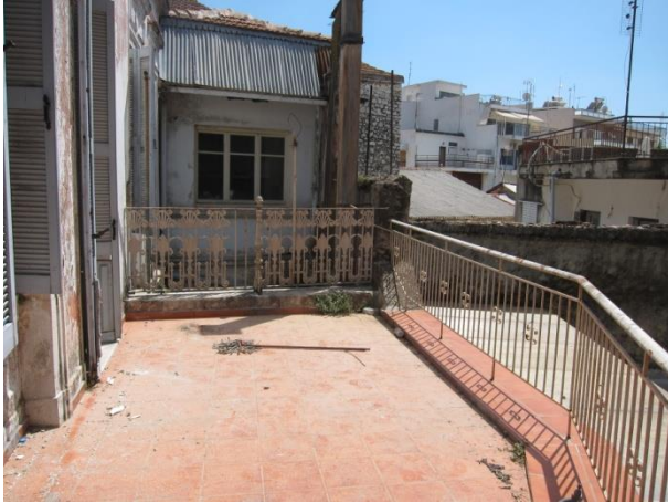
Εικ. 4.4.9. Άποψη της βεράντας. Στα δεξιά διακρίνονται τα νεώτερα κάγκελα, τα οποία θα αφαιρεθούν και θα συνεχιστεί το κτιστό στηθαίο που βρίσκεται εκατέρωθέν τους.
