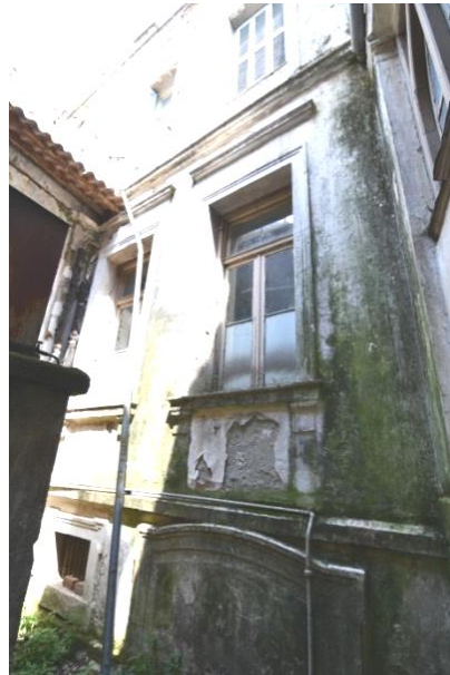
Εικ. 4.3.2. Η ίδια θύρα από τον ακάλυπτο 1. Προτείνεται επίσης η αποκάλυψη και συντήρηση των λίθινων βαθμίδων που οδηγούν στο κατώφλι της και στον χώρο Υ-2.
