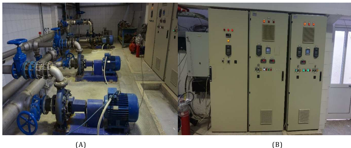
ΕΙΚΟΝΑ 4: ΔΕΞΑΜΕΝΗ ΣΤΗΝ ΟΔΟ ΣΤΡΑΤΩΝΟΣ ΔΗΜΟΥ ΑΡΤΑΙΩΝ, (Α): ΑΝΤΛΙΕΣ, (Β): ΚΕΝΤΡΙΚΟΣ ΗΛΕΚΤΡΟΛΟΓΙΚΟΣ ΠΙΝΑΚΑΣ
