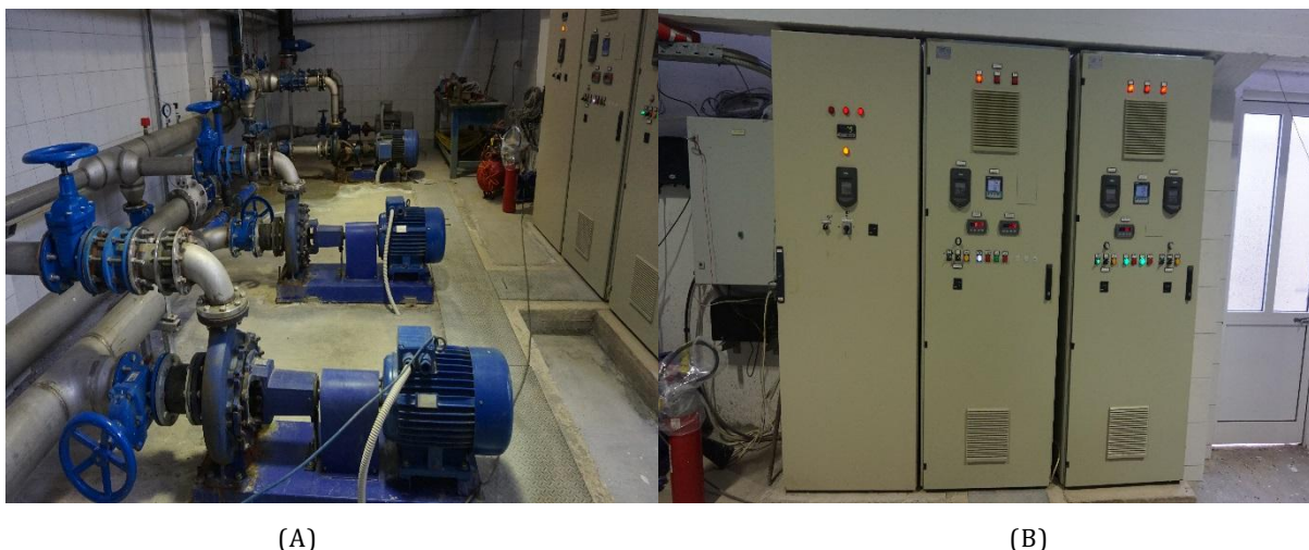
ΕΙΚΟΝΑ 11: ΔΕΞΑΜΕΝΗ ΣΤΗΝ ΟΔΟ ΣΤΡΑΤΩΝΟΣ ΔΗΜΟΥ ΑΡΤΑΙΩΝ, (Α): ΑΝΤΛΙΕΣ, (Β): ΚΕΝΤΡΙΚΟΣ ΗΛΕΚΤΡΟΛΟΓΙΚΟΣ ΠΙΝΑΚΑΣ
