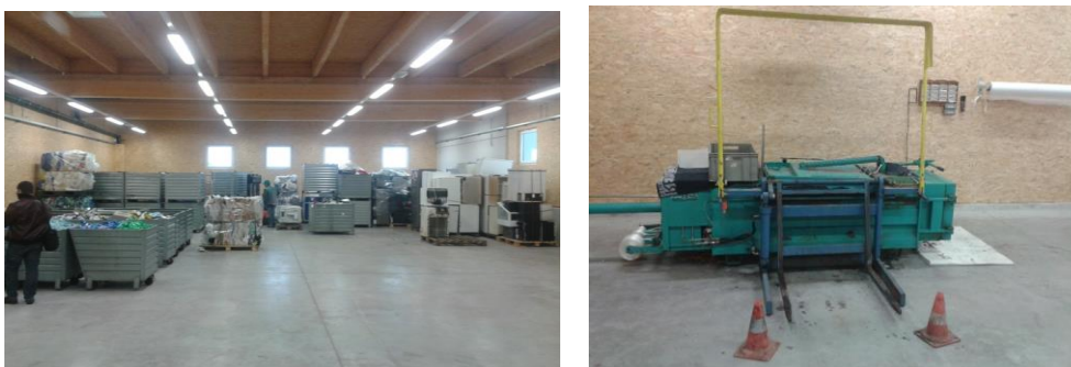
Εικόνα 18: Χώρος αποθήκευσης συμπίεσης μικρών ανακυκλώσιμων αποβλήτων
